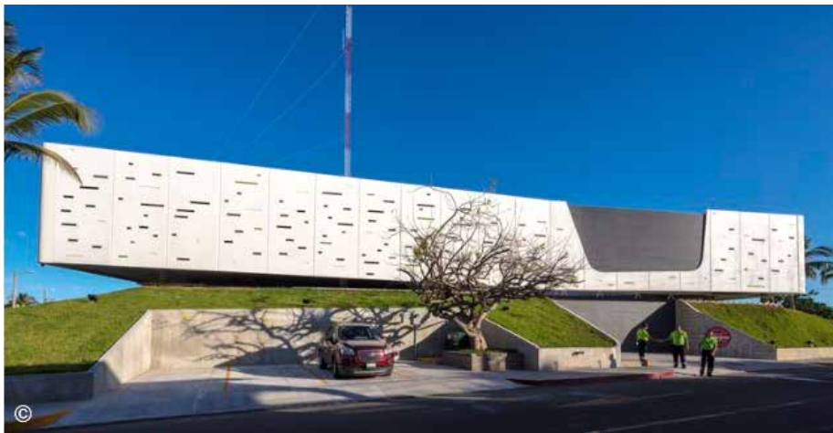
Figura 1. Fachada Fuente: https://www.plataformaarquitectura.cl/cl/885257/estacion-de-bomberos-boca-taller-diez-05 (2017)
