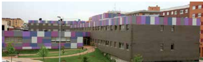
Figura 1: Fachada principal de La Casa Malva. Tomado de Hurtado, K. (2016), p. 39.
