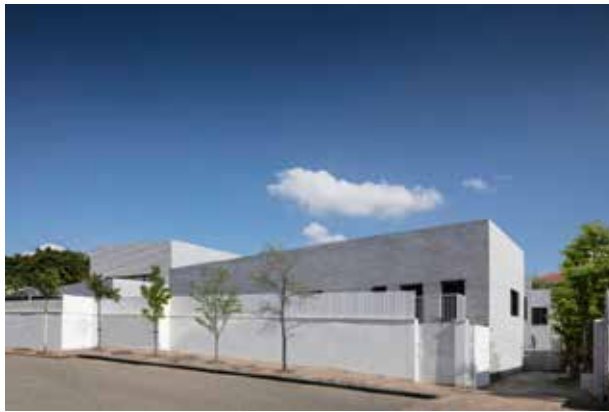
Figura 7: Fachada principal del Refugio. Tomado de Arch Daily [Revista en línea] (2018).
