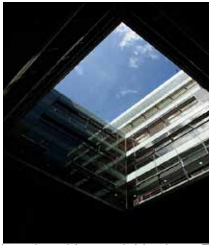
Figura 2: Plaza descubierta a doble altura. Fuente: http://www.plataformaarquitectura.cl/cl/750095/nueve-sede-de-alcaldia-de-baruta-franco-micucci-dalessandri
