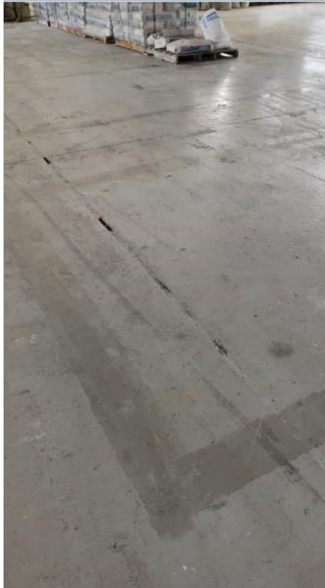
Figura 2 Falta de visualización del rayado en el almacén Fuente: Suministrado por la empresa Inversiones PintaPro, C.A. (2022).
