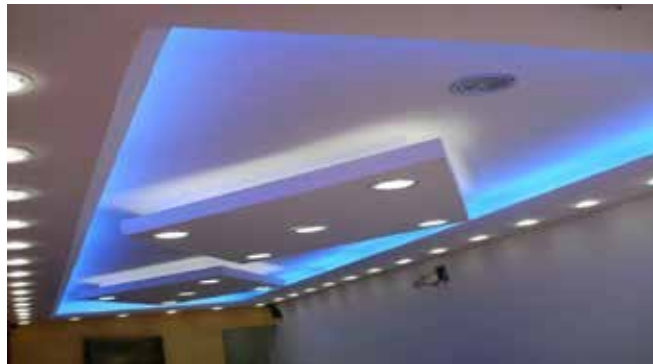
Figura 21 Acabado en Drywall http://mycmontero.pe/drywall-cielo-raso.php
