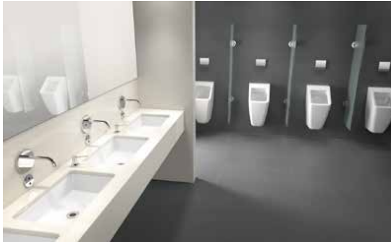
Revestimiento de los baños y sanitarios de la Edificación.
