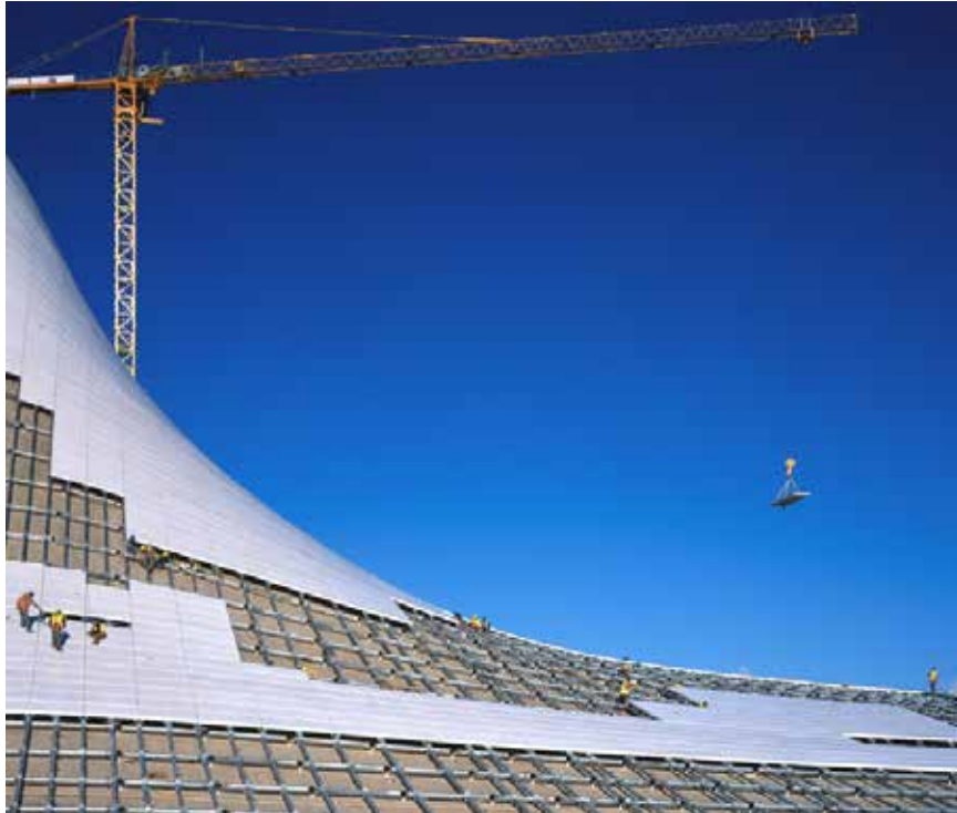
Posicionamiento de láminas de Corian en el recubrimiento exterior de la malla espacial. : https://www.adelto.co.uk/construction-of-heydar-aliyev-center-by-zaha-hadid/zaha-hadid-heydar-aliyev-center-construction-adelto-11/
