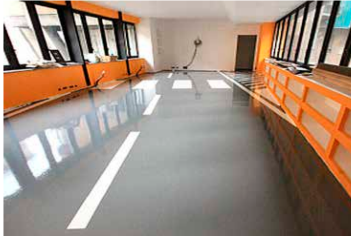
Acabo de piso de la Fábrica – Pavimento de Resina Epoxi.
