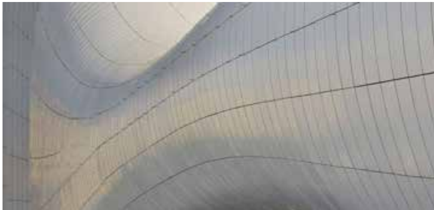
Vista de revestimiento de láminas exteriores – Corian.
