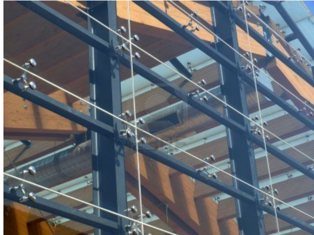
Fachada de Muro Cortina con paneles de vidrio flotantes.
