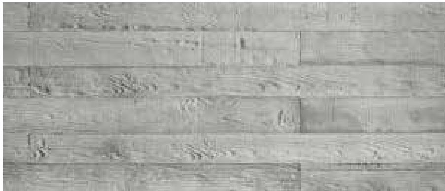
Figura 24: Losa de Concreto pulido. Fuente: http://www.loveandproductivity.com/2017/02/18/concreto-aparente-en-la-arquitectura-e-interiorismo (2018)
