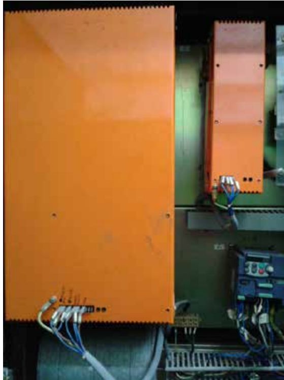
Figura 13: Convertidor Alimentador / AC- DC Fuente: Elaboración propia (2017)
