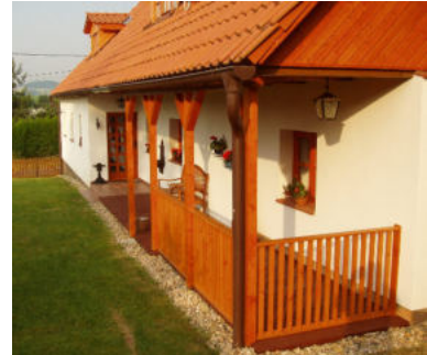
Figura.65. Sistema estructural pórtico de madera.
