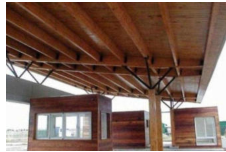
Figura.19. Vigas de madera en Valencia.
