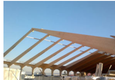
Figura.17. Viga de madera.
