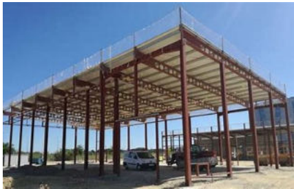
Figura.16. Vigas de acero en San Diego.
