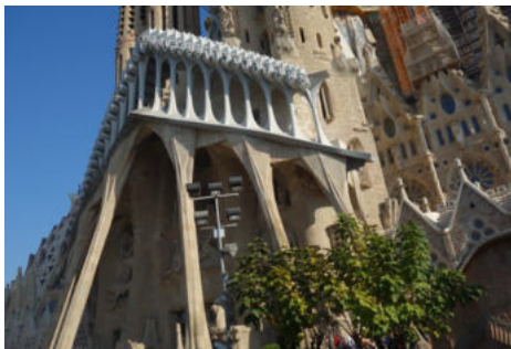
Figura.69 Idealización de sistema estructural con columnas inclinadas.
