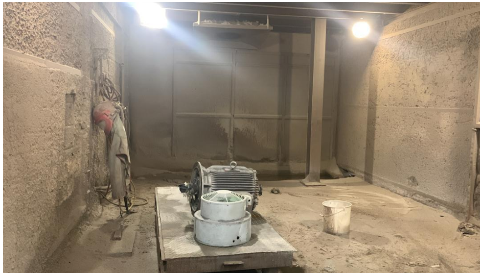
Figura 6. Área de Sandblasting.
