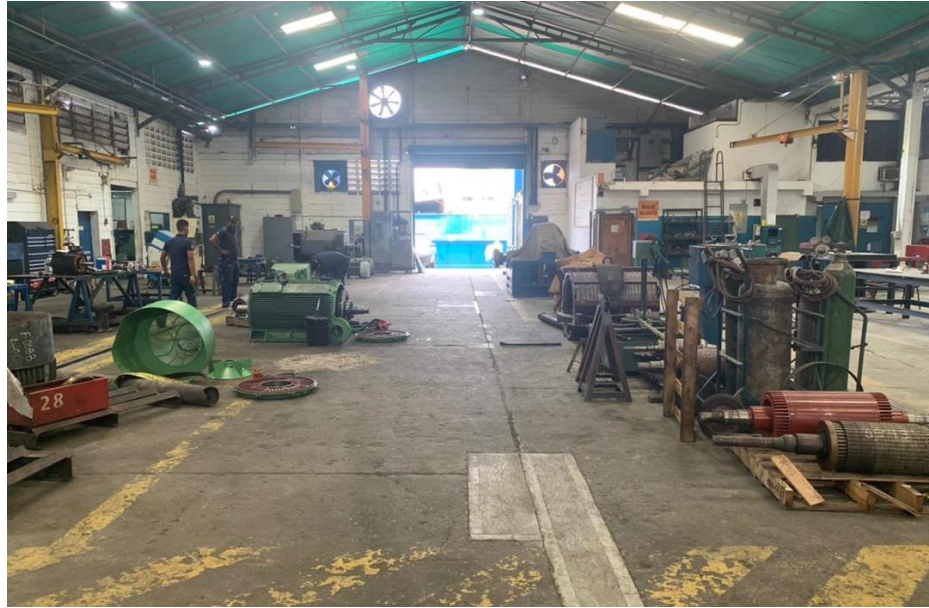
Figura 2. Área de Mecánica de baja y media tensión. Fuente: Departamento de Producción SIDELCA C.A.
