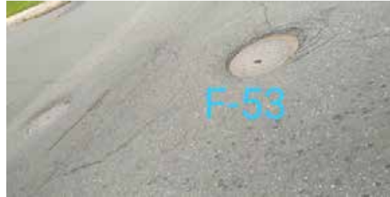
Falla 53: Falla en boca y hundimiento 0.9x0.9x0.12m Fuente: Crialese I., Capuzzi L. (2019)
