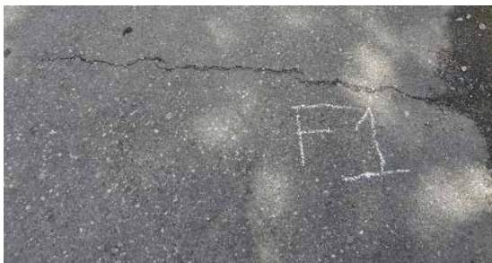
Falla 1: Falla transversal de 0.1x1.8m Fuente: Crialese I., Capuzzi L. (2019)
