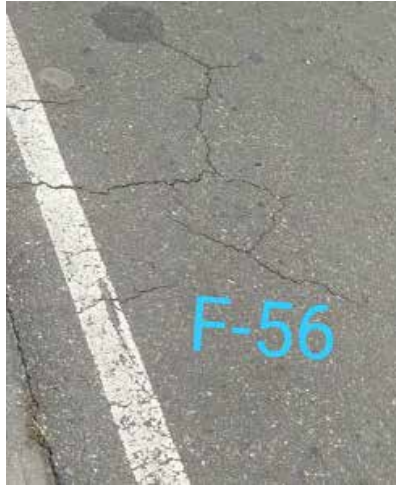
Falla 56: Falla de borde de 95x3.1m Fuente: Crialese I., Capuzzi L. (2019)
