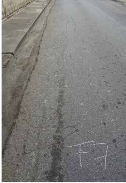
Falla 7: Falla de Borde y Piel de cocodrilo de 23.4x0.75m Fuente: Crialese I., Capuzzi L. (2019)
