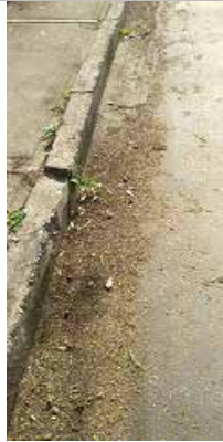
Falla 5: Falla de borde de 2.4x0.15m Fuente: Crialese I., Capuzzi L. (2019)
