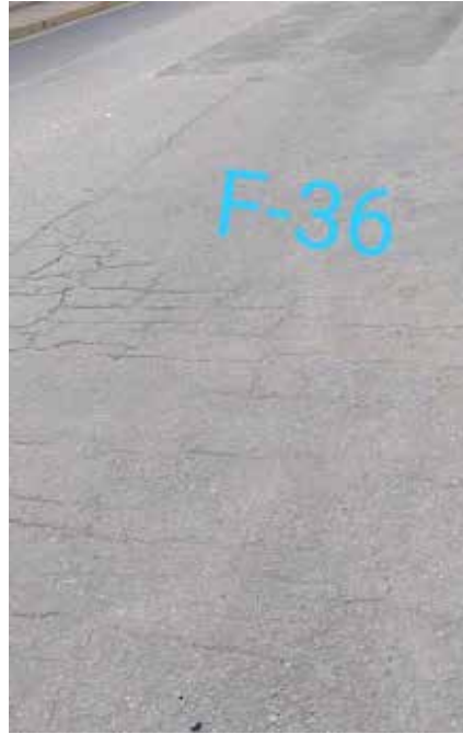
Falla 36: Piel de cocodrilo y falla longitudinal de 22.7x2.8m Fuente: Crialese I., Capuzzi L. (2019)
