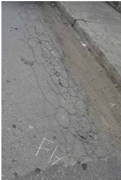
Falla 17: Falla de Borde y Piel de cocodrilo de 14.5x0.7m Fuente: Crialese I., Capuzzi L. (2019)
