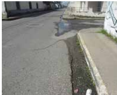
Figura 56. Intersección entre Calle Valencia y Calle Bermúdez, se aprecia como los tramos de calzada no siguen una línea recta. Fuente: Capuzzi L. y Crialese I. (2019).
