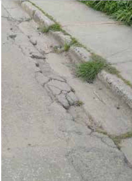
Falla 27: Falla de borde de 1.8x0.5m Fuente: Crialese I., Capuzzi L. (2019)
