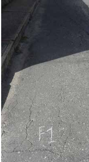
Falla 1: Falla de borde de 22.87x0.50m Fuente: Crialese I., Capuzzi L. (2019)
