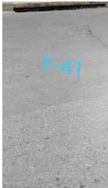
Falla 41: Falla transversal causada por los sumideros de ventana de 2x6.4m Fuente: Crialese I., Capuzzi L. (2019)
