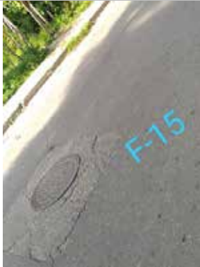
Falla 15: Falla de borde de 24x0.2m Fuente: Crialese I., Capuzzi L. (2019)
