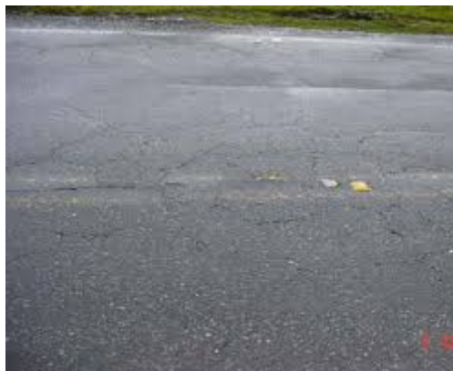
Figura 24. Fisura incipiente.
