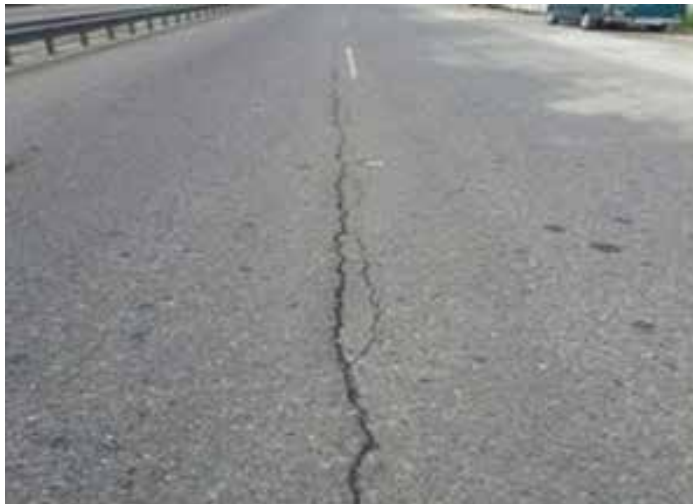
Figura 18. Fisura longitudinal.
