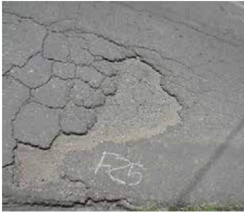
Falla 25: Piel de cocodrilo de 7.7x140m y bache de 1x1x0.03m Fuente: Crialese I., Capuzzi L. (2019)
