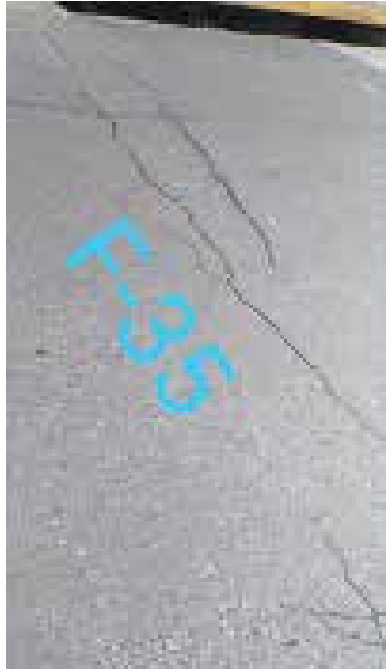
Falla 35: Falla transversal causada por los sumideros de ventana de 2x6.4m Fuente: Crialese I., Capuzzi L. (2019)
