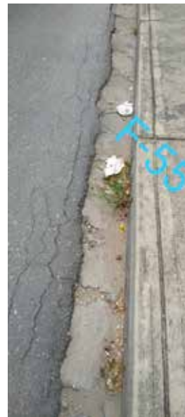
Falla 55: Falla de borde de 61x0.3m Fuente: Crialese I., Capuzzi L. (2019)
