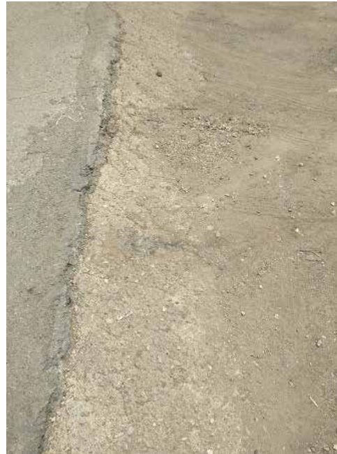
Falla 2: Falla de borde de 6.2x0.2m Fuente: Crialese I., Capuzzi L. (2019)
