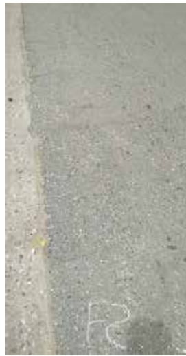
Falla 2: Falla de borde de 37.5x0.40m Fuente: Crialese I., Capuzzi L. (2019)
