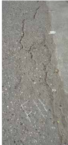
Falla 11: Falla de borde de 2.6x1m Fuente: Crialese I., Capuzzi L. (2019)
