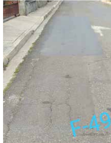
Falla 49: Falla de borde de 53x0.2m Fuente: Crialese I., Capuzzi L. (2019)
