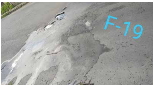
Falla 19: Piel de cocodrilo y falla longitudinal de 45.1x3m y bache de 4.9x3x5cm Fuente: Crialese I., Capuzzi L. (2019)
