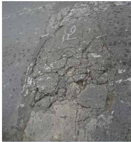
Falla 6: Piel de cocodrilo sobre un reductor de velocidad de 0.9x2.73m Fuente: Crialese I., Capuzzi L. (2019)
