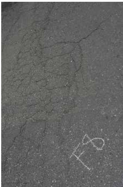
Falla 6: Fisura transversal de 0.05x5.1m Fuente: Crialese I., Capuzzi L. (2019)
