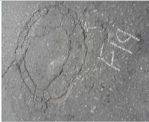
Falla 19: Falla en boca (tapada) 0.9x0.9m Fuente: Crialese I., Capuzzi L. (2019)
