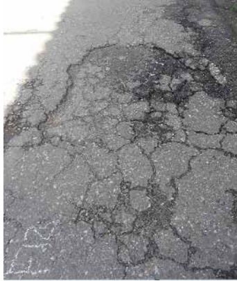
Falla 12: Piel de cocodrilo de 4.44x1.62m con un Bache de 1.1x1.2x0.03m Fuente: Crialese I., Capuzzi L. (2019)
