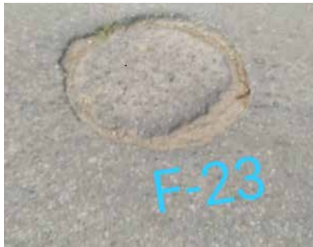
Falla 23: Falla de boca de 0.9x0.9 Fuente: Criaiese I., Capuzzi L. (2019)
