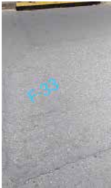
Falla 33: Falla transversal causada por los sumideros de ventana de 2x6.4m Fuente: Criaiese I., Capuzzi L. (2019)
