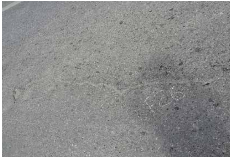
Falla 27: Falla longitudinal y piel de cocodrilo de 24.3x6.3m Fuente: Crialese I., Capuzzi L. (2019)
