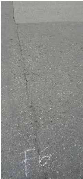
Falla 6: Fisura transversal de 0.05x5.1m Fuente: Crialese I., Capuzzi L. (2019)
