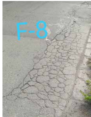
Falla 8: Piel de cocodrilo y falla de borde de 13x1.5m Fuente: Crialese I., Capuzzi L. (2019)
