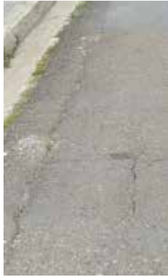
Falla 43: Falla de borde de 11x0.3m Fuente: Crialese I., Capuzzi L. (2019)
