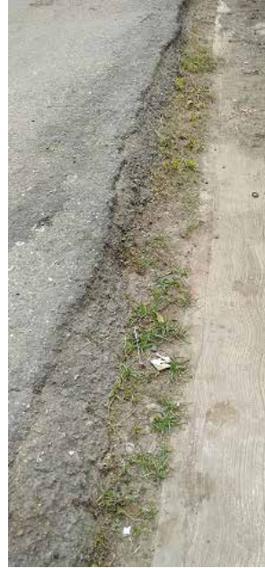
Falla 5: Falla de borde de 46.3x0.4m Fuente: Crialese I., Capuzzi L. (2019)
