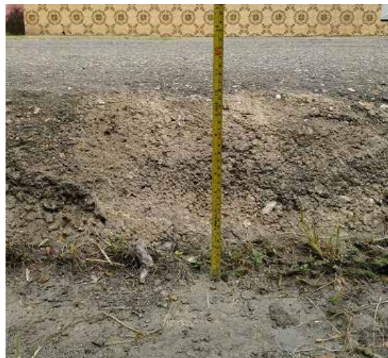
Falla 5: Falla de borde de 46.3x0.4m Fuente: Crialese I., Capuzzi L. (2019)
