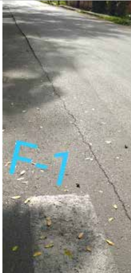
Falla 1: Hundimiento y falla longitudinal de 9.31x1.5x0.05m Fuente: Crialese I., Capuzzi L. (2019)
