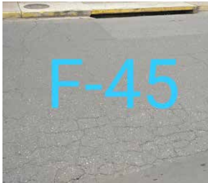
Falla 45: Falla transversal causada por los sumideros de ventana de 2x6.4m Fuente: Crialese I., Capuzzi L. (2019)
