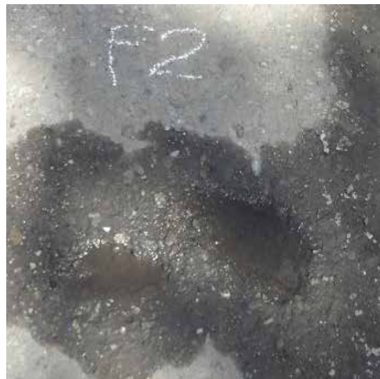
Falla 1: Falla transversal de 0.1x1.8m Fuente: Crialese I., Capuzzi L. (2019)
