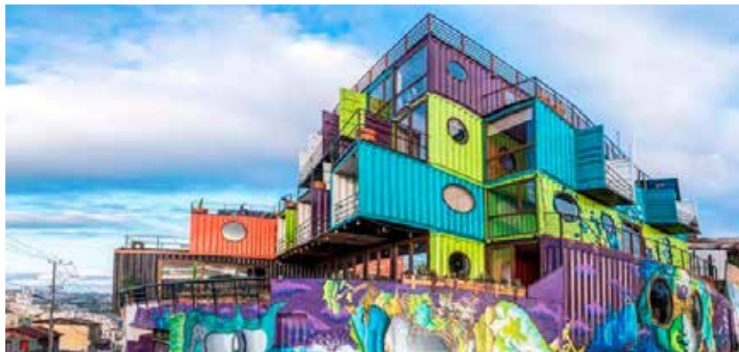
Figura 3. Fachada posterior del hotel Winebox Valparaíso.
