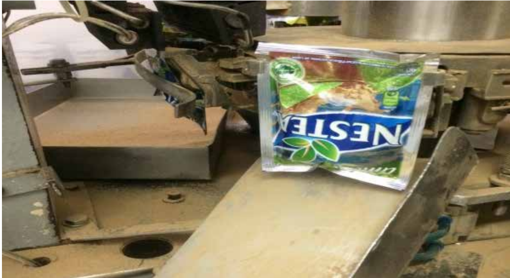
Figura 15. Sistema de Llenado Actual Fuente: Estrada, O y Sthory, G. (2017)
