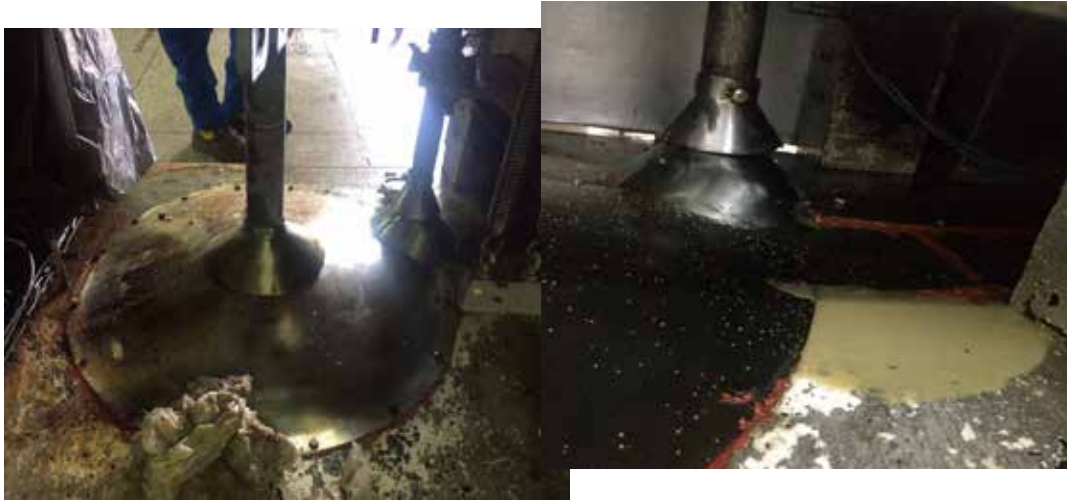
Figura 8. Derrames de aceite y agua en el piso alrededor de la máquina Fuente: Estrada, O y Sthory, G. (2017)
