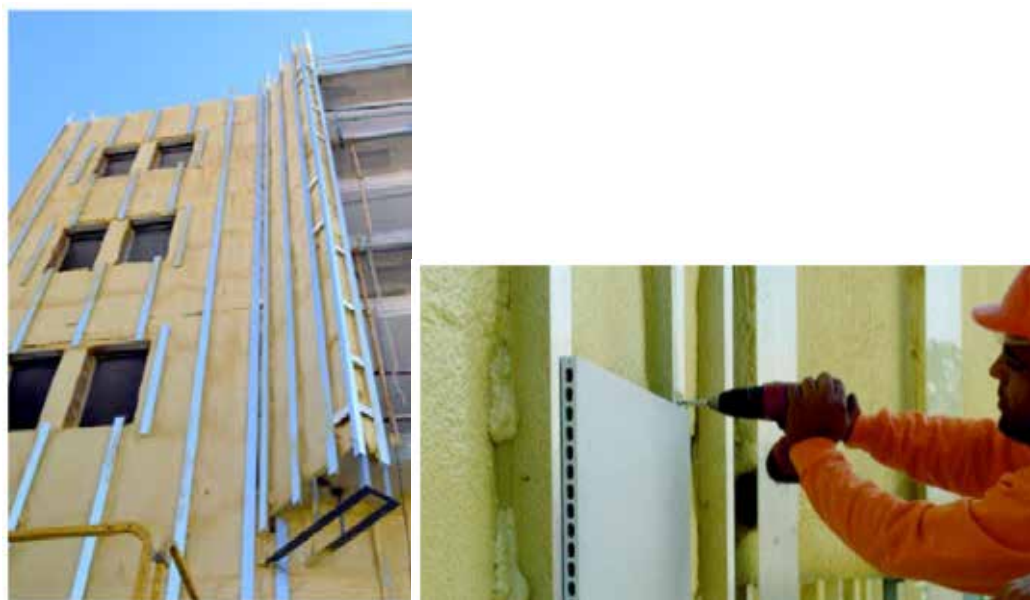
Figura 40: Sistema de Fijación. Cerámica Tecnológica Frontek. Fuente: Catalogo Frontek de Greco Gres. (2015).
