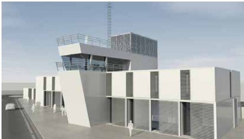
Figura 2: Edificio de Servicios Náuticos, España.
