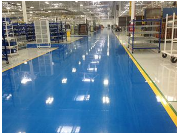
Figura 54: Acabado de Piso Epóxico, Área de Taller.
