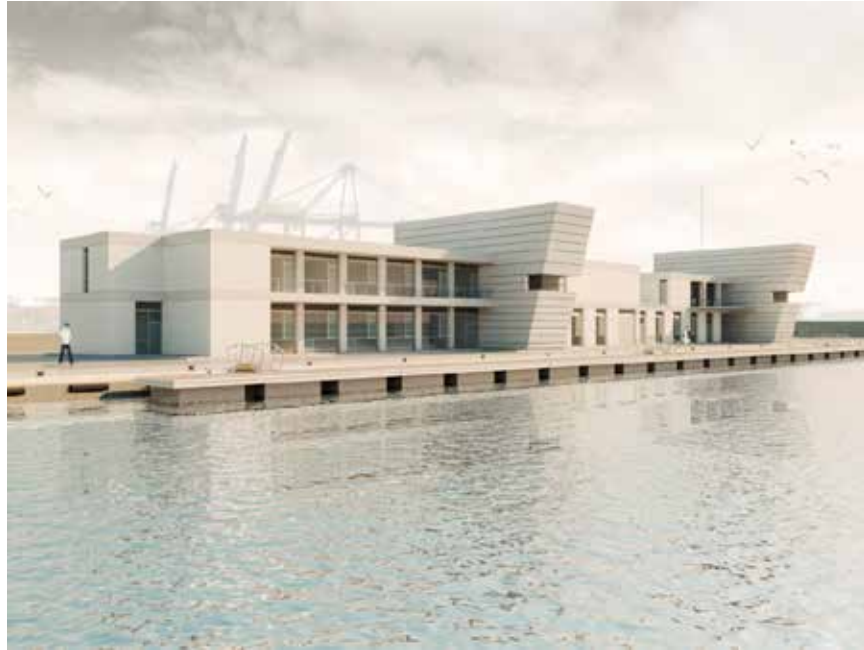
Figura 3: Edificio de Servicios Náuticos, España.
