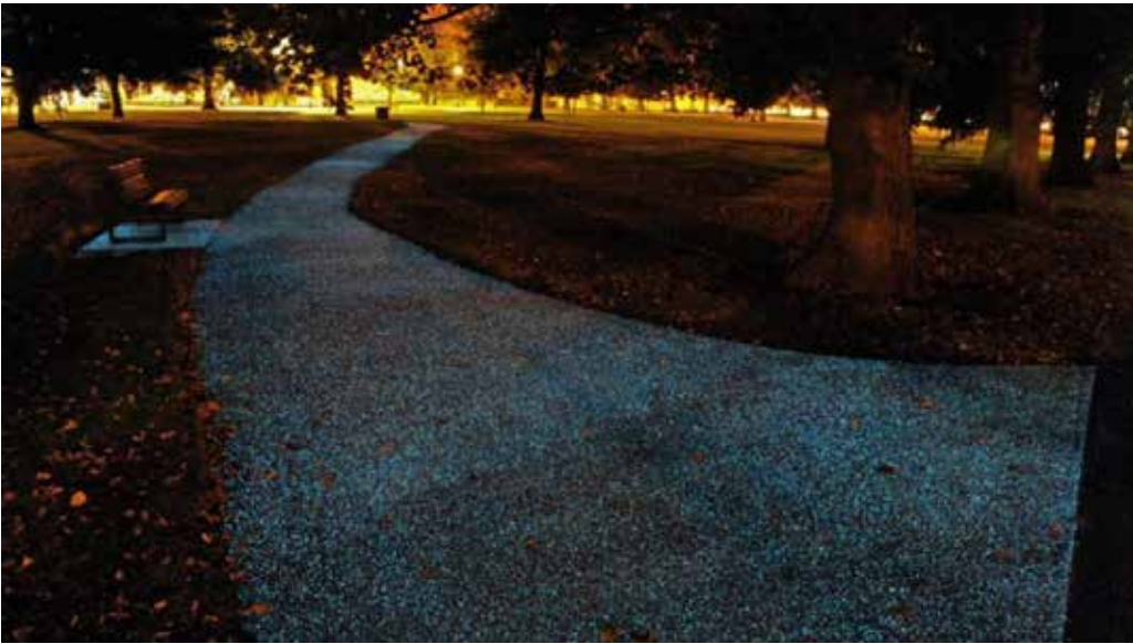
Acabado de concreto luminiscente en caminerías
