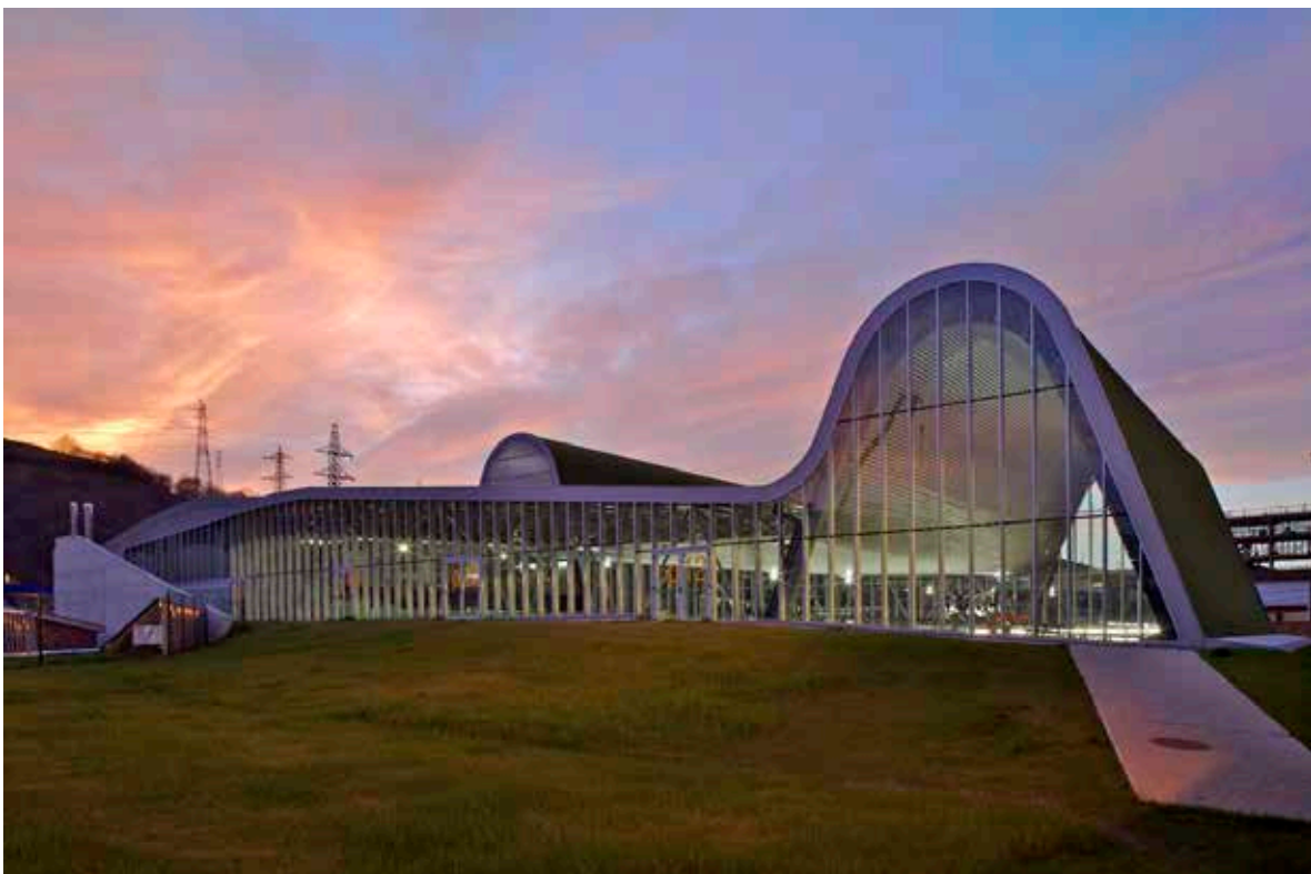
Fachada principal Centro Deportivo y de Ocio
