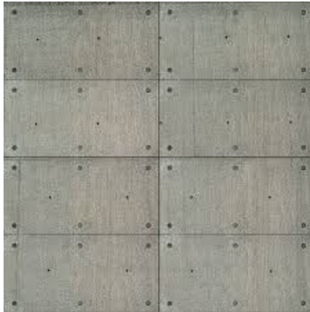
Concreto Expuesto – Acabado final
