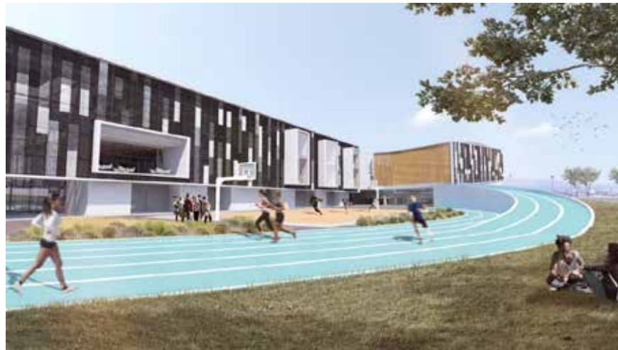
Área exterior Centro Deportivo Alto Rendimiento
