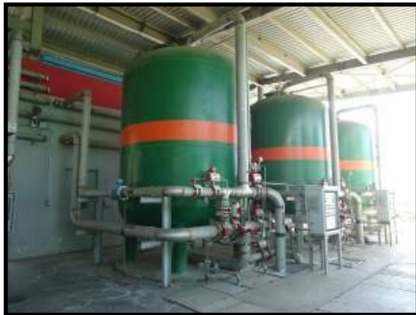
Figura 14. Filtros de carbón activado Autor: Niño, J. Troset, F (2018)
