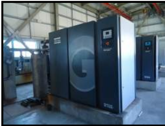
Figura 6. Compresor de aire #2
