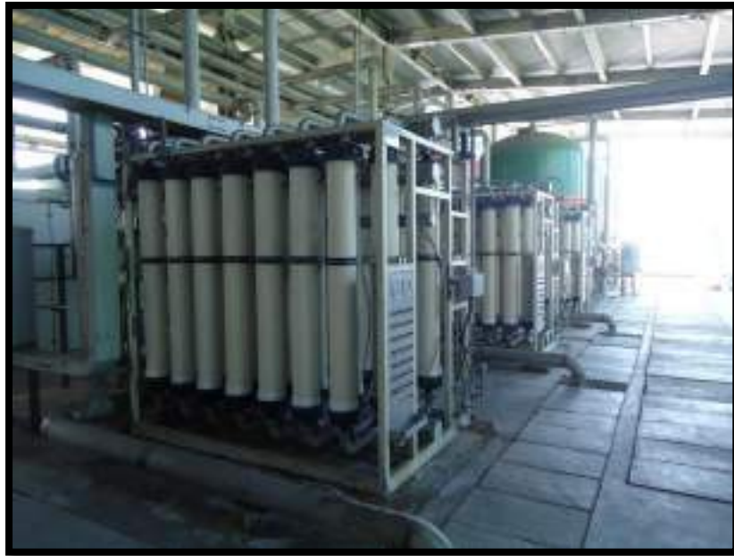
Figura 15. Tren de ultrafiltrado, primera fase Autor: Niño, J. Trosel, F (2018)
