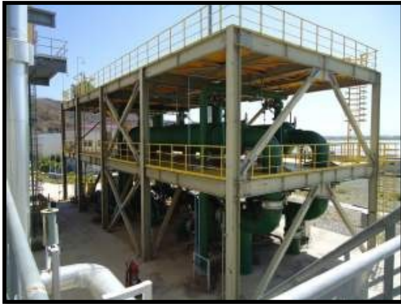
Figura 21. Edificio de enfriamiento OCW-CCW Autor: Niño, J. Trosel, F (2018)
