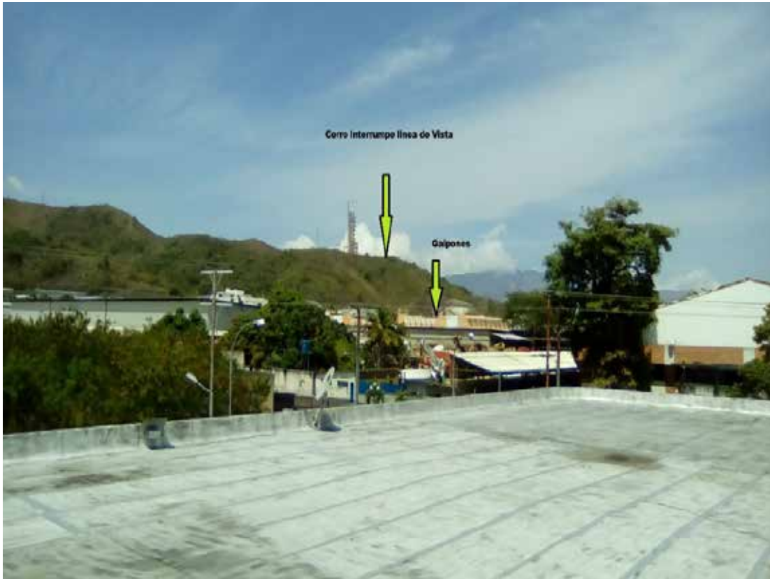
Figura 11. Obstáculos línea de vista enlace actual.
