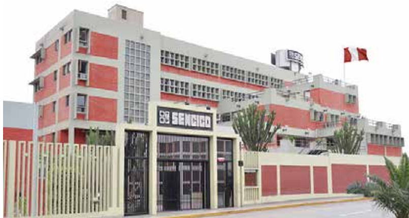
Figura 1: Sede del Servicio Nacional de Capacitación para la Industria de la Construcción Fuente: http://www.sencico.gob.pe/publicaciones.php?id=128 (1976)
