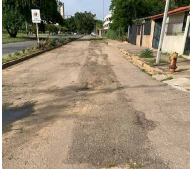
Figura 95: Disgregación
