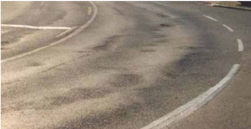
Figura 23: Deformación por empuje
