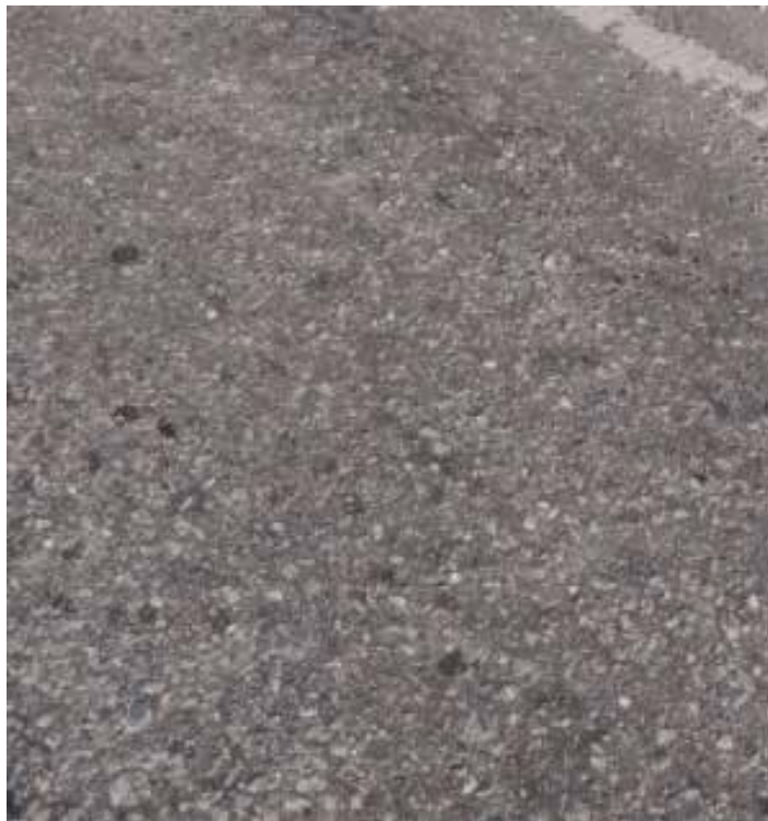
Figura 64: Disgregación
