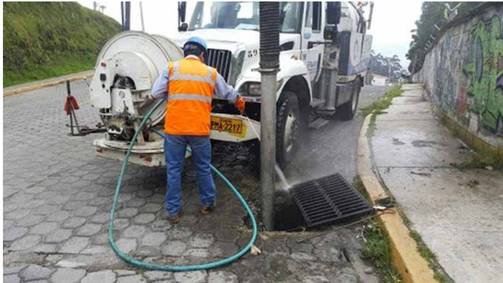
Figura 7: Limpieza de sumideros de ventana
