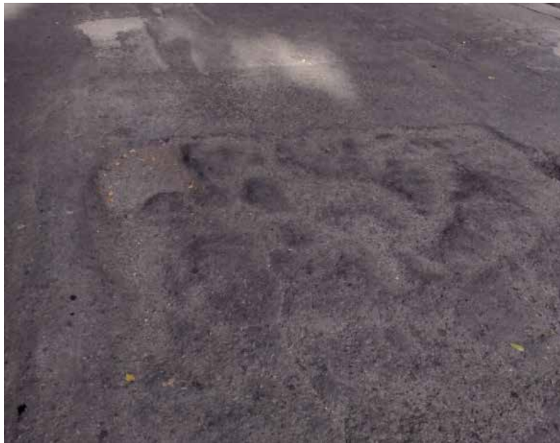
Figura 86: Falla por empuje
