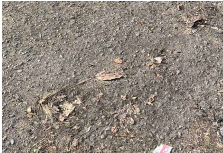
Figura 72: Disgregación
