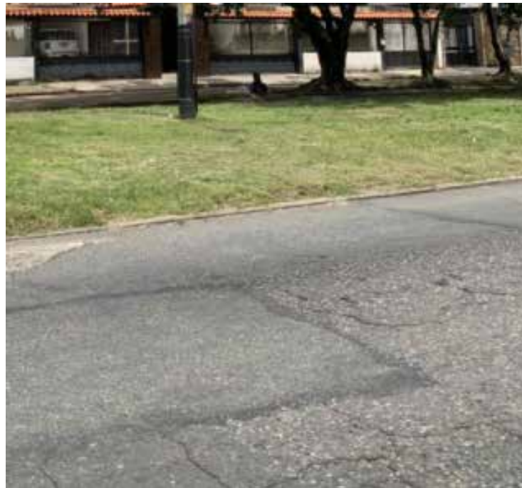
Figura 68: Disgregación
