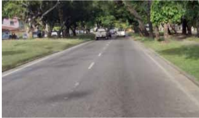
Figura 49: Disgregación
