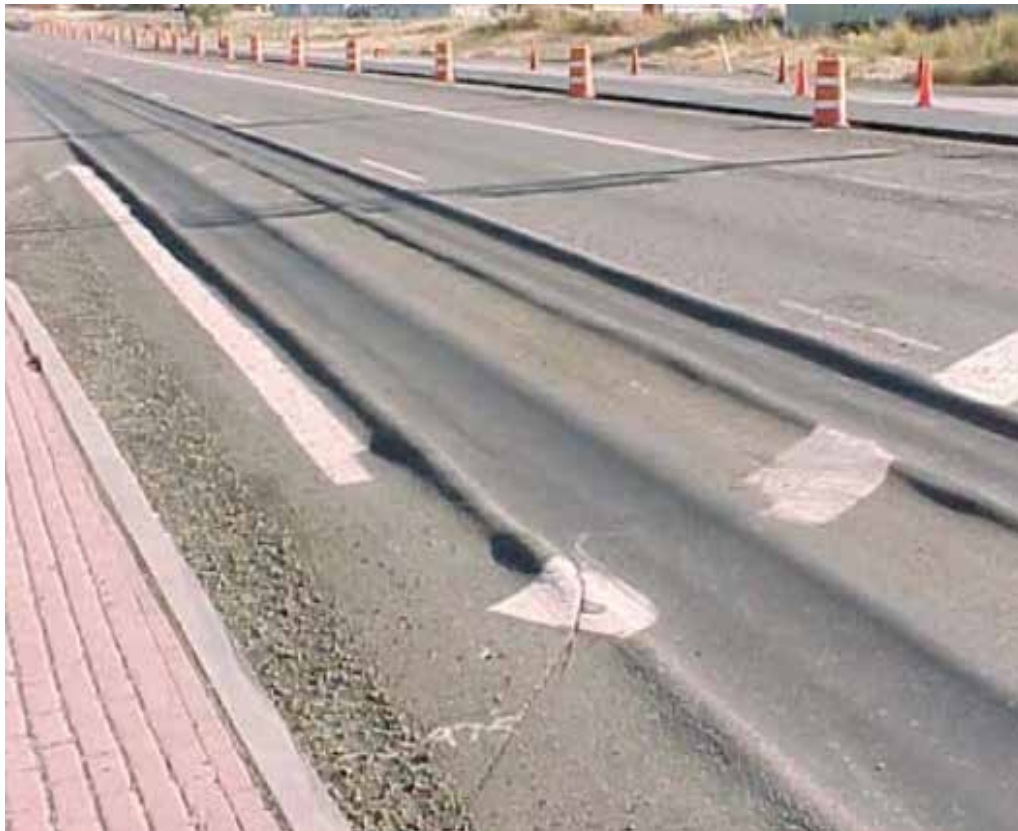
Figura 22: Ahuellamientos
