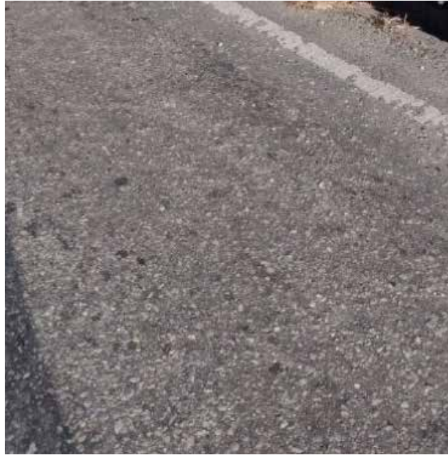
Figura 51: Disgregación
