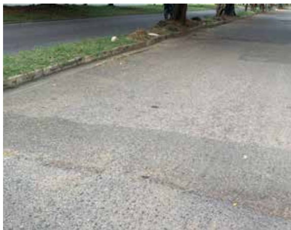
Figura 88: Disgregación
