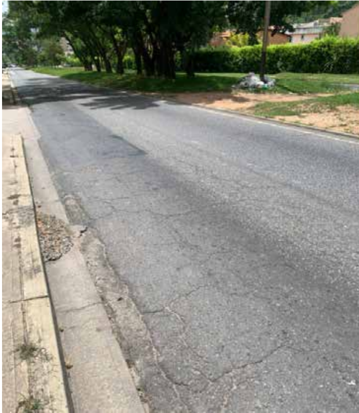
Figura 71: Grietas transversales
