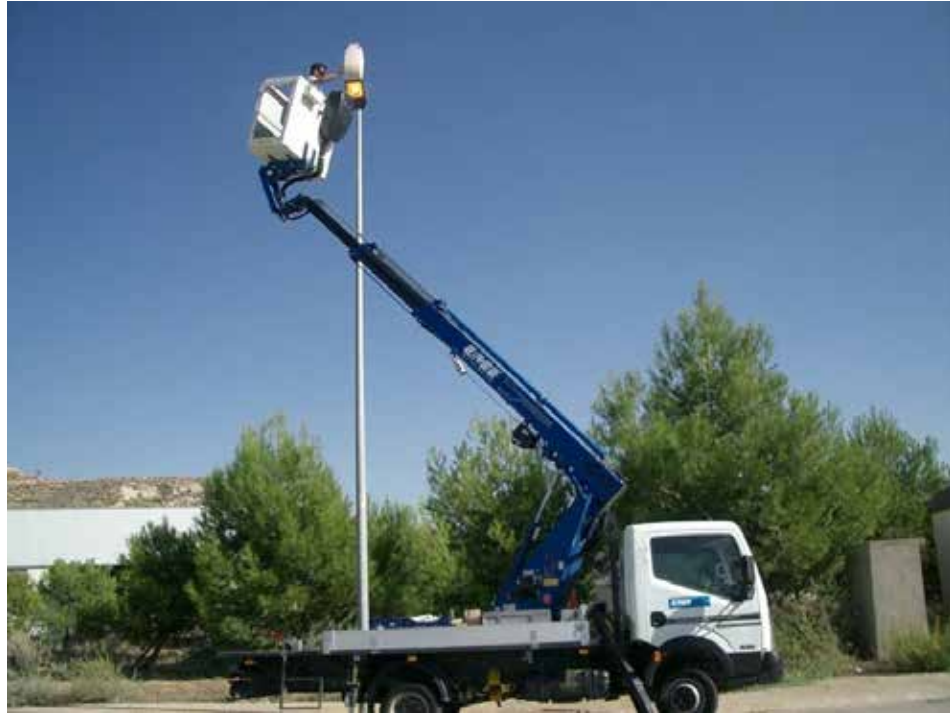
Figura 5: Reemplazo de lámpara incandescente
