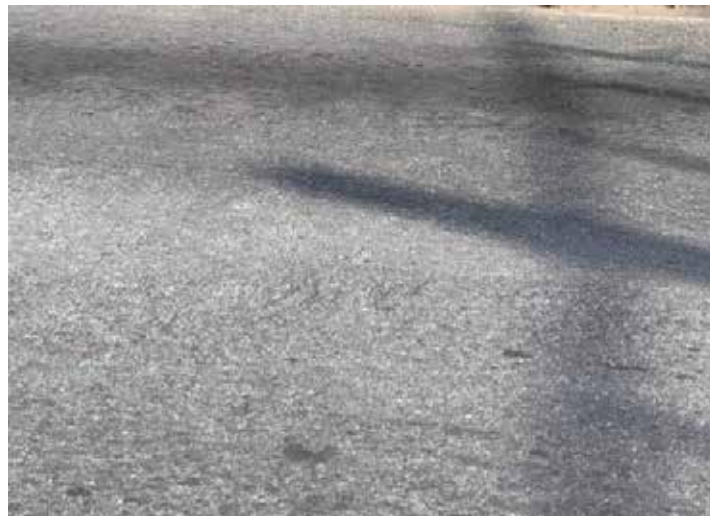
Figura 56: Disgregación
