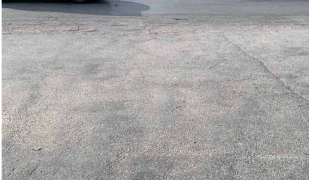
Figura 61: Disgregación
