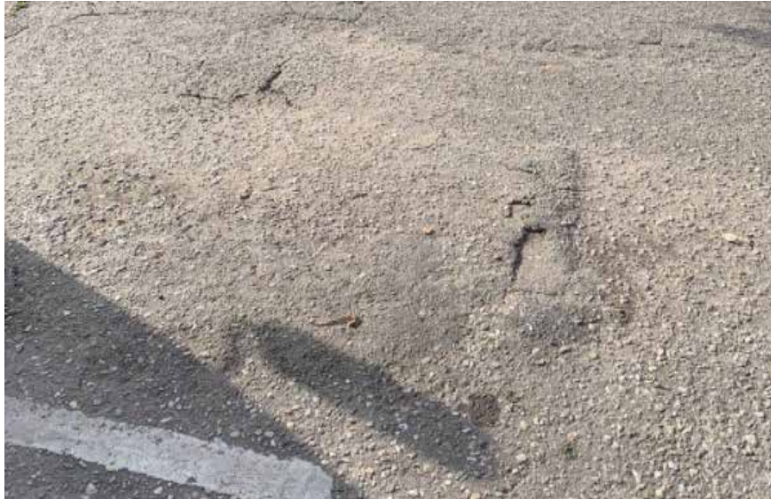
Figura 83: Disgregación
