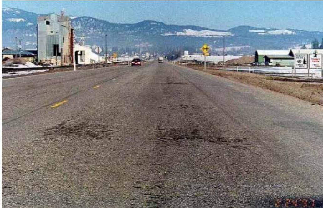
Figura 26: Disgregación y desintegración
