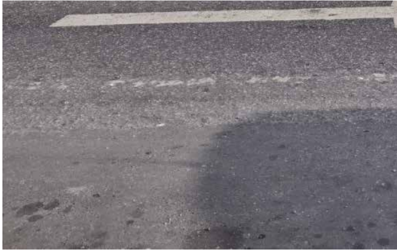
Figura 47: Disgregación
