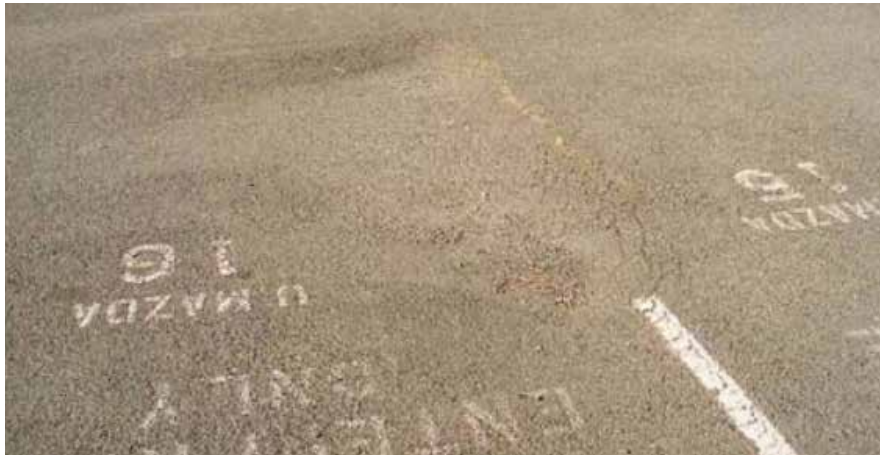
Figura 11: Elevación y/o hundimientos
