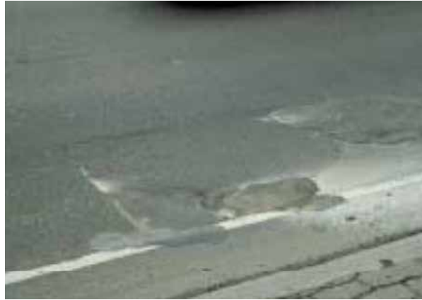
Figura 18: Bacheo y zanjas reparadas
