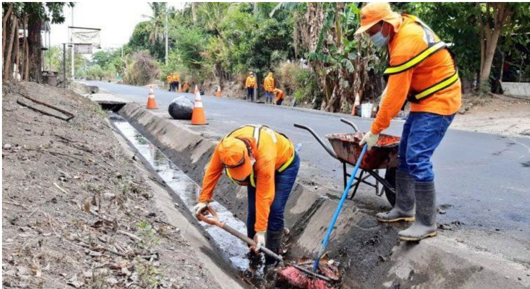
Figura 8: Limpieza de canaletas
