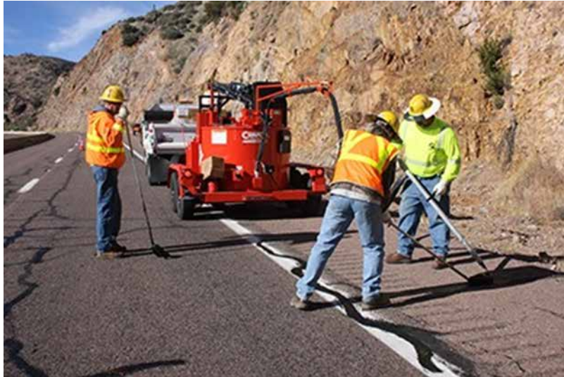
Figura 9: Sellado de grietas
