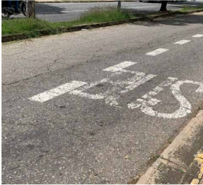
Figura 93: Disgregación
