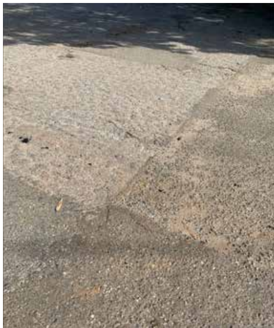
Figura 80: Disgregación
