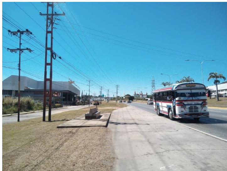
Figura 29. Evidencia Fotográfica de Paradas Peatonales Ficticias Cerca del Centro Comercial Pino Cauchos. (Arvelaiz 2023)
