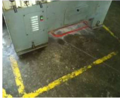
Figura 2. Condiciones del Rayado alrededor de las maquinas. Autor: Sánchez, Losavio (2019)
