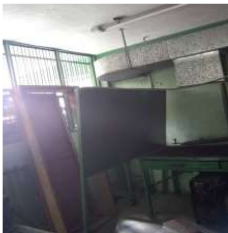
Figura 13. Condiciones de trabajo del taller de soldadura
