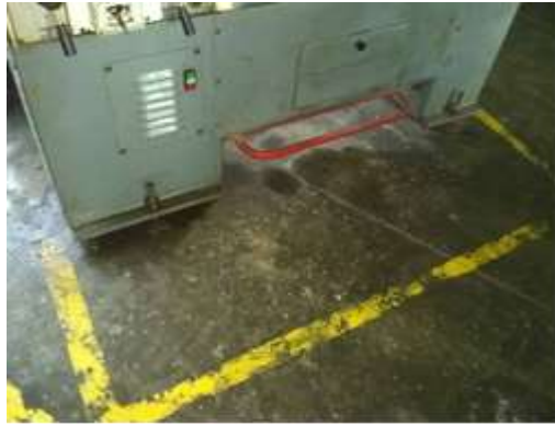
Figura 14: Rayado de seguridad Desgastado Autor: Losavio, Sánchez. (2020)
