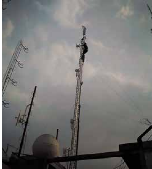
Figura 32: Torre venteada de Conex Telecom en Cerro Copey Fuente: El Autor
