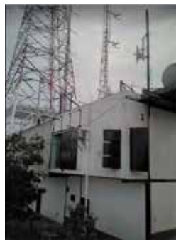
Figura 31: Caseta de comunicación en Cerro Copey
