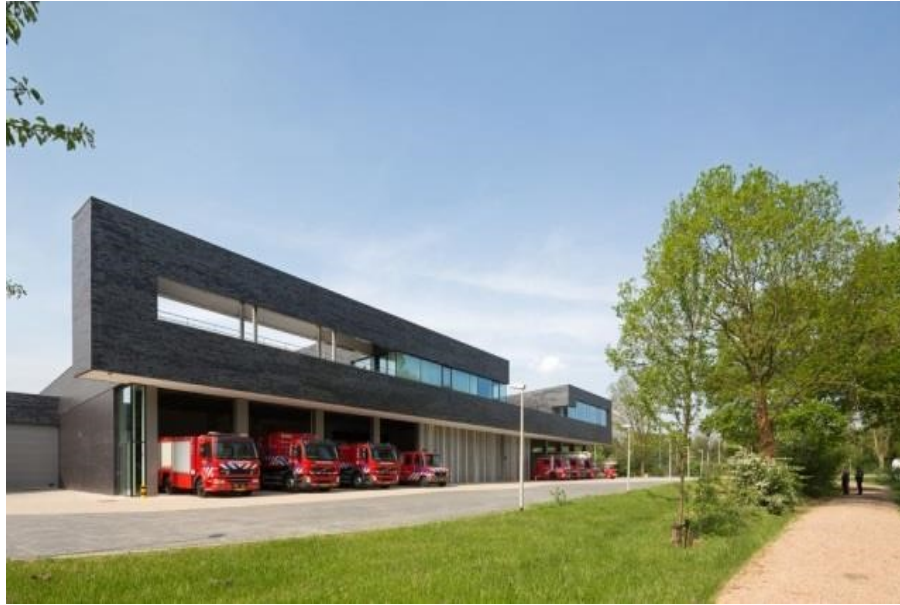
Figura 2. Estación de Bomberos en Doetinchem. Fuente: http://www.bekkeringadams.nl/projects/57/fire-station (2015).
