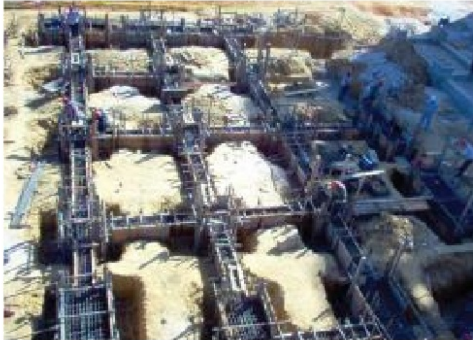
Figura 30: vigas de riostra. Fuente: http://columnasdeconcreto.blogspot.com/2012_07_01_archive.html (2012)
