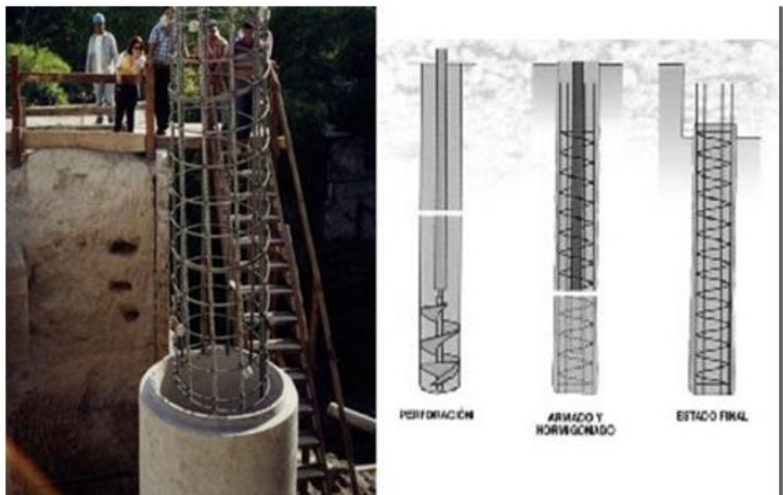
Figura 29. Fundaciones profundas. Fuente: http://civilgeeks.com/2011/12/01/elementosestructurales-pilotes-zapatras-soleras-de-fundacion-tensores/ (2011)
