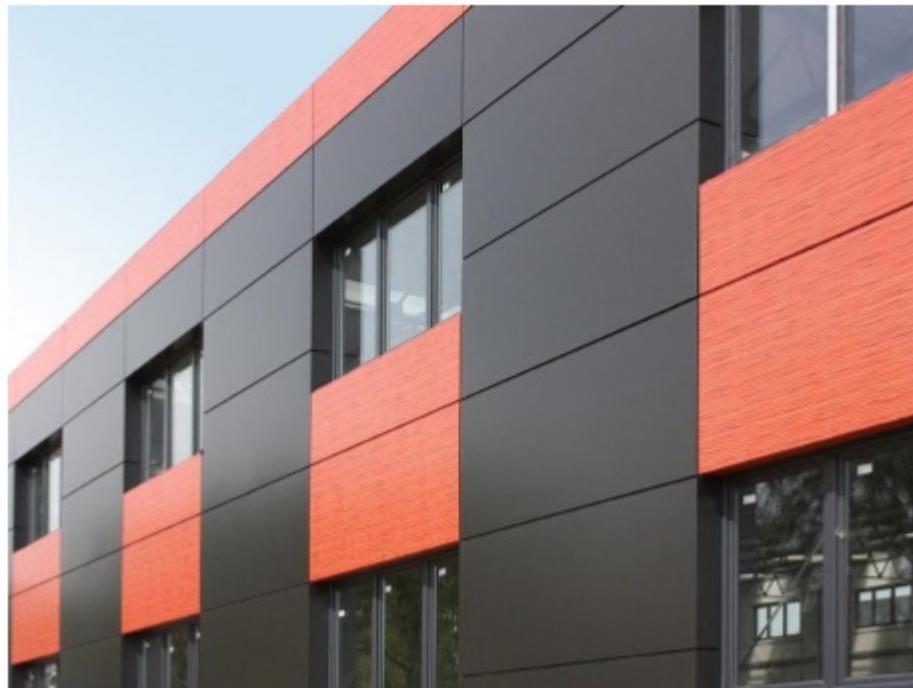
Figura 24. Paneles de aluminio compuesto.
