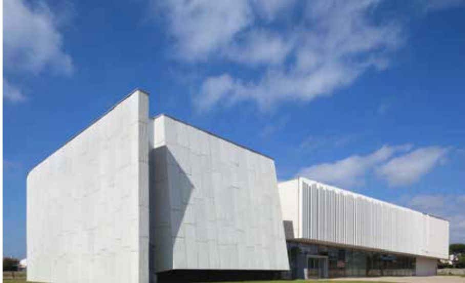
Figura 3: Escuela de Arte Carcassonne. Fuente: https://www.plataformaarquitectura.cl/cl/763739/escuela-de-arte-carcassonne-jacques-ripault-architecture (2015).
