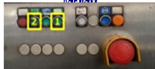
Imagen #28. Panel de control usas de entrada del paletizador
