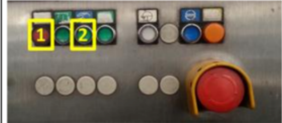
Imagen #11. Tablero control de mando del paletizador
