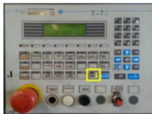
Imagen #6. Panel de control del Robopac
