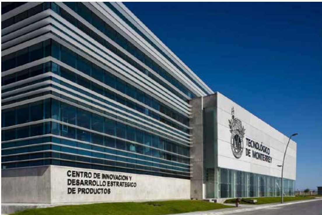
Figura 5: Centro de Innovación y Desarrollo estratégico de productos del Tecnológico de Monterrey. Jim Stephenson. Fuente: Plataforma Arquitectura (2013)
