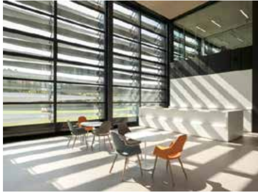
Figura 44: Parasoles metálicos en fachadas Fuente: https://www.plataformaarquitectura.cl/
