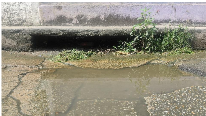
Figura 42: Sumidero lateral o de ventana presente en el tramo 3 y 4 Fuente: Puerta – Chacón (2022)
