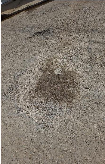
Falla por disgregación de materiales Fuente: Puerta y Chacón (2022)
