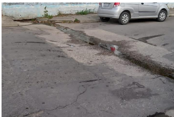
Figura 44: Drenaje tipo batea con rejilla presente en el tramo 7 y 8 Fuente: Puerta – Chacón (2022)
