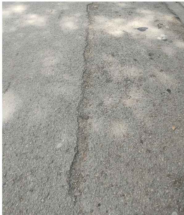
Falla por disgregación de materiales Fuente: Puerta y Chacón (2022)
