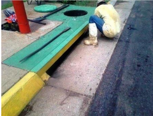
Figura 14: Obreros del mantenimiento
