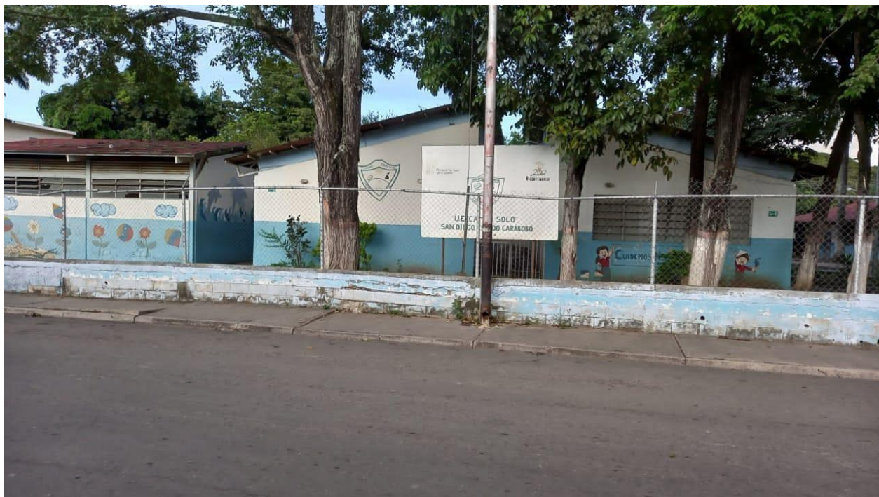
Escuela con falta de señalización como “zona educacional, Reduzca velocidad” Fuente: Puerta y Chacón (2022)
