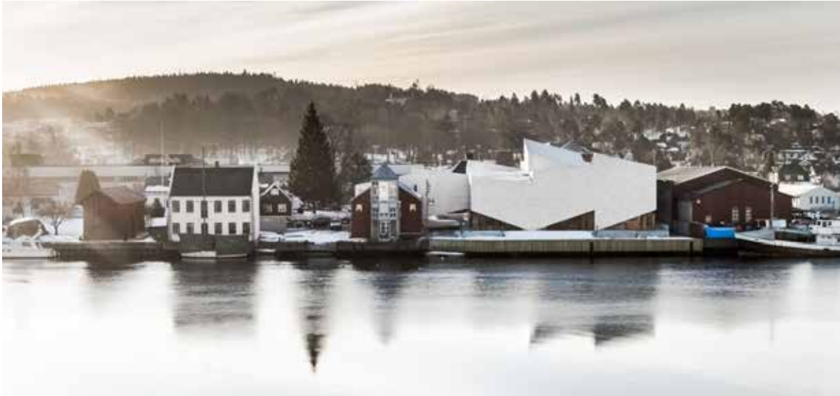
Figura 2. Museo Marítimo y Exploratorio de Noruega. Fuente: http://www.plataformaarquitectura.cl/cl/02-320306/nuevo-museo-maritimo-y-exploratorio-cobe-architects-transform-architects (2013).
