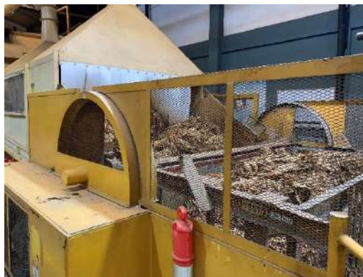
Figura 5. Condiciones actuales Feeder en área de Alimentación y Acondicionado
