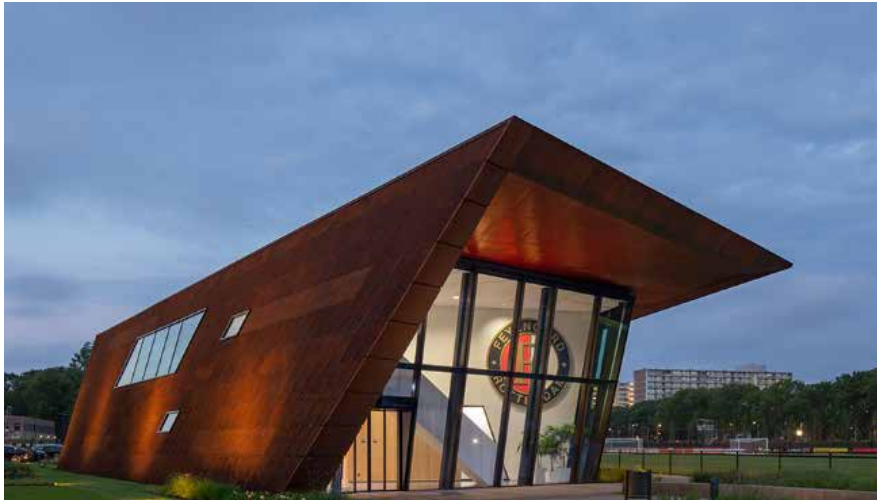
Figura2 Complejo de entrenamiento, Rotterdam Feyenoord. Fuente https://arqa.com/arquitectura/complejo-de-entrenamiento-rotterdam-feyenoord.html
