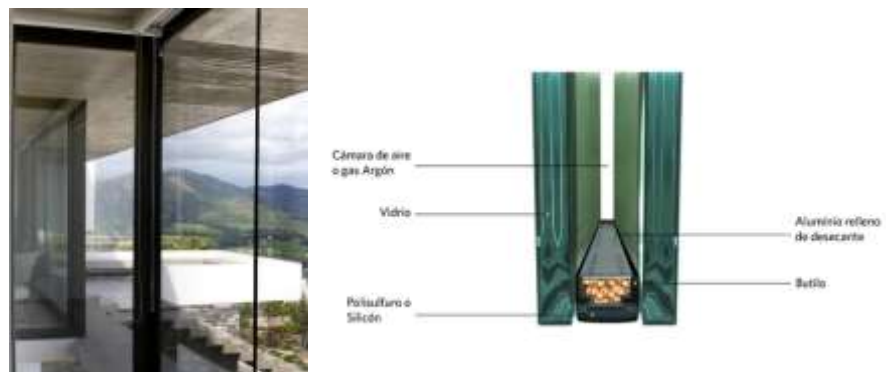
Figura 24. Fachada exterior Administracion. Glasstech. (2021). Fuente en línea:
