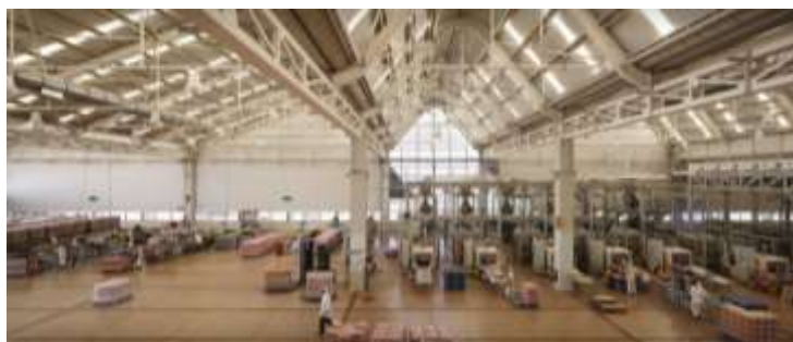
Figura 2. Vista Interna “Centro de Producción e Investigación Carozzi, 2015” Fuente: Guillermo Hevia (2015)
