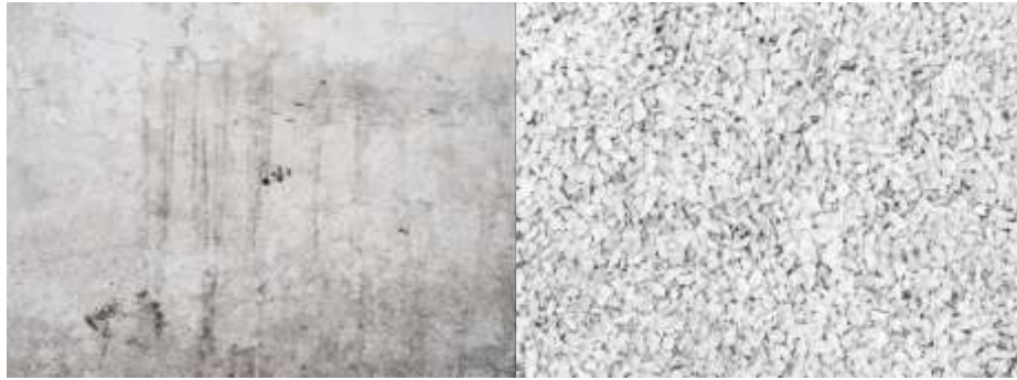
Figura 28. Piso Externo. Cemento texturizado; Gravilla (2020). Fuente en línea: https://psiconcreto.com/pisos-epoxicos-todo-lo-que-debes-saber/
