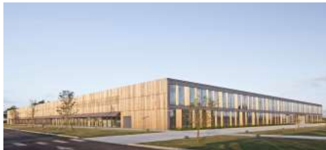
Figura 8. Exterior Fábrica Berluti, 2015. Fuente: Barthélémy Griño Architectes (2015)
