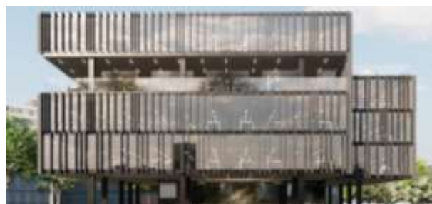
Figura 25. Fachada exterior administracion. Cietra (2021). Fuente en línea:
