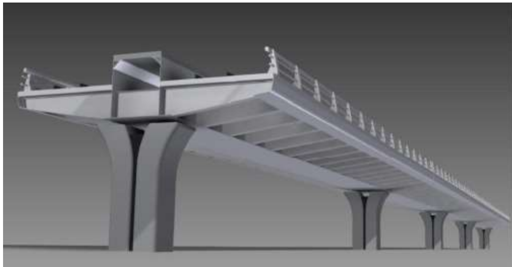
Figura 40. columnas en concreto armado
