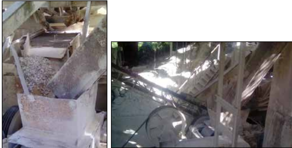
Figura 11. Zaranda vibratoria y banda transportadora del mineral a la Criba Fuente: Acuña, 2018
