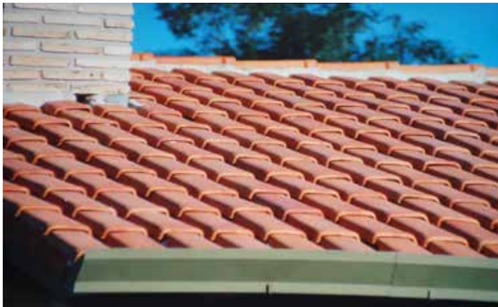
Figura 48. Tejas romanas color tradicional aplicadas en techo inclinado de una vivienda unifamiliar. Fuente: http://ceramicairene.com.py/?cirene_productos=tejas-romanas-2
