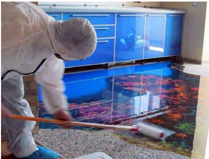
Figura 44. Aplicación de porcelanato líquido en una sala sanitaria. Fuente: http://suelosporcelanato.com/liquido/que-es-el-porcelanato-liquido/
