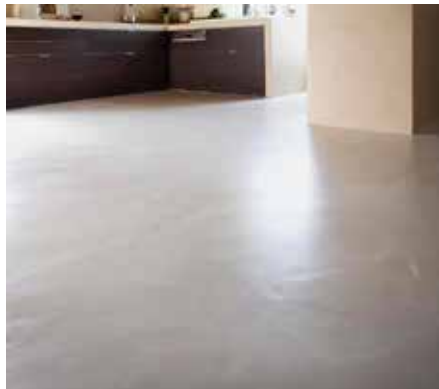
Figura 42. Acabado de piso en cemento pulido. Fuente: http://www.mineralrevest.com/microcemento-alisado/
