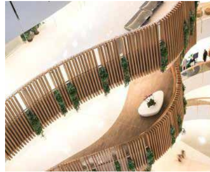
Figura 25. Barandas de madera
