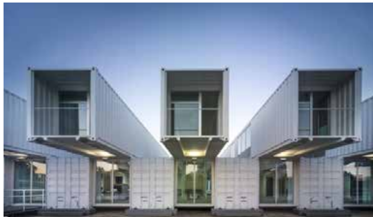
Figura 4. Fachada principal del terminal de cruceros de Sevilla, fotografía de Jesús Granada
