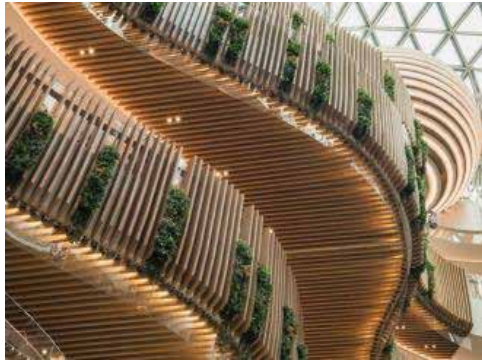
Figura 24. Barandas de madera
