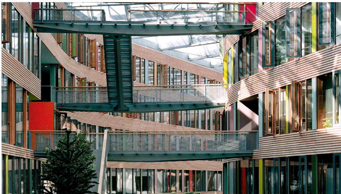
Figura 2: Agencia Federal de Medio Ambiente. Fuente: Arquitectura viva
