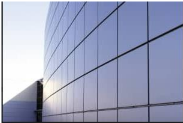
Figura 23. Fachada doble piel con paneles de aluminio compuesto. Fuente: Google (2021).
