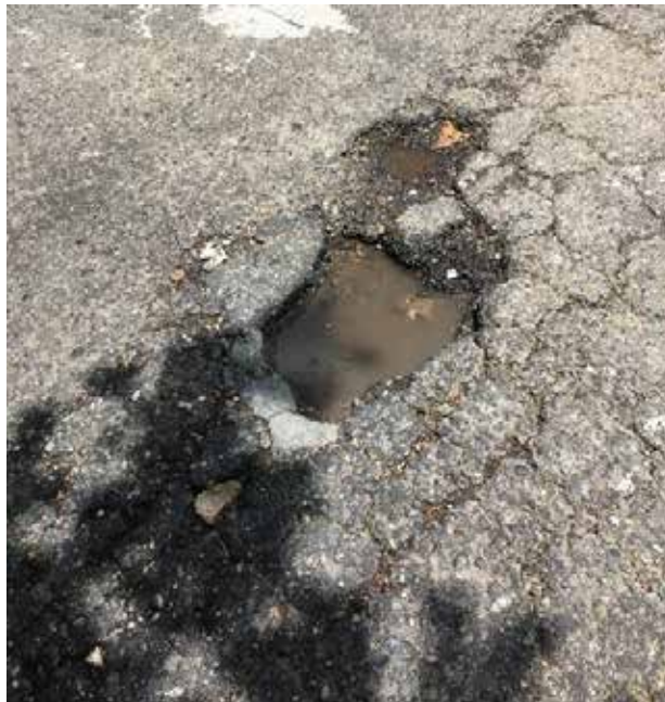
Figura 73: Piel de cocodrilo con hueco.
