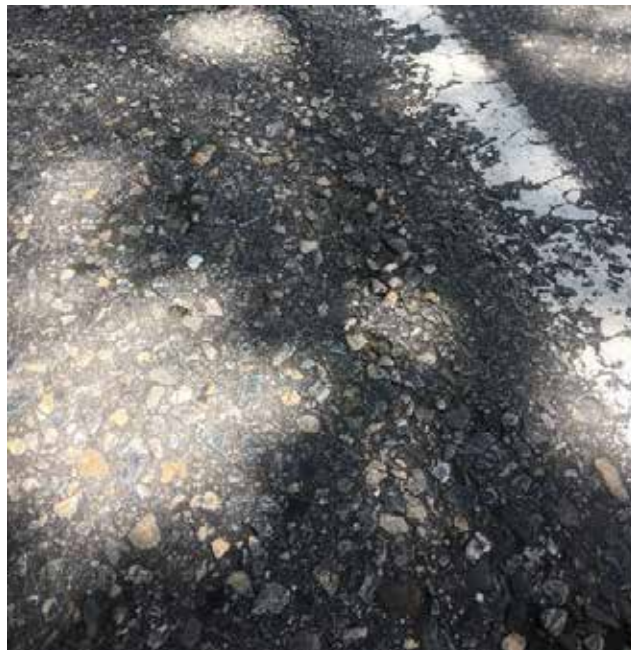
Figura 51: Pulimiento del Agregado.
