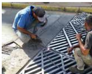
Figura 106: Reparación de alcantarillas
