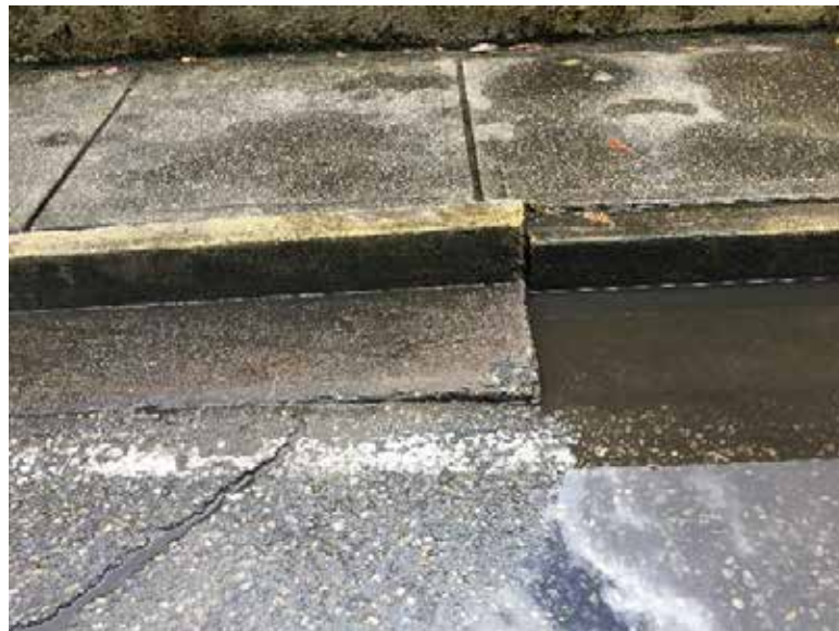
Figura 69: Levantamiento de la cuneta y el brocal.
