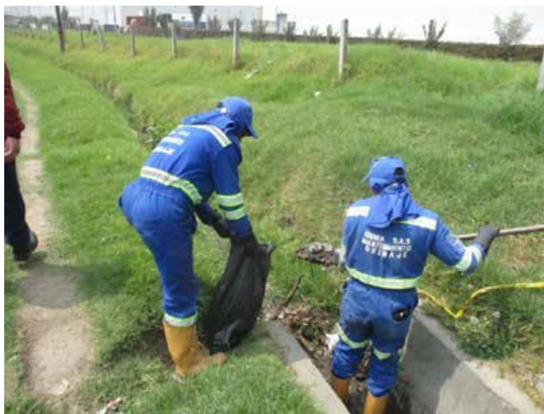
Figura 91: Limpieza de los drenajes
