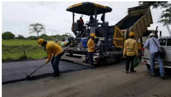
Figura 100: Escarificación y repavimentación de la carpeta asfáltica.
