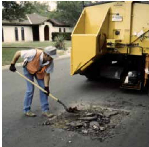
Figura 101: Bacheo y reparaciones
