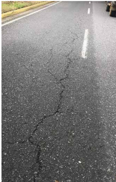
Figura 49: Fisura longitudinal.
