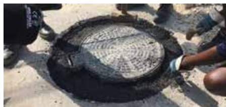
Figura 105: Reparación de alcantarillas
