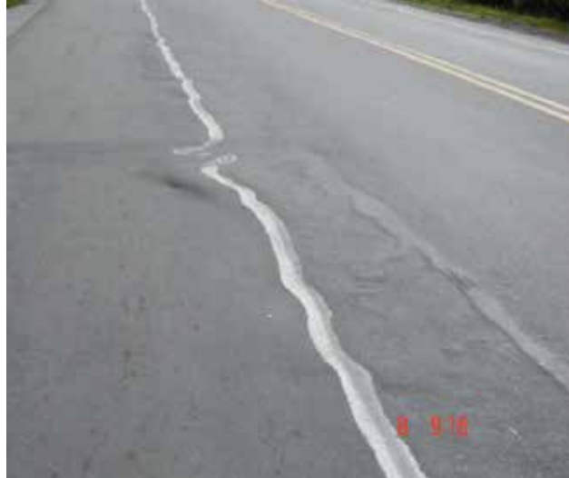
Figura 19: Ejemplo de Ondulación.
