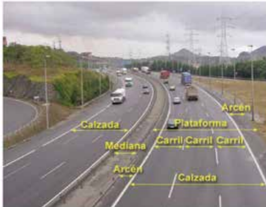
Figura 2: Dibujo de Partes que Componen una Vía
