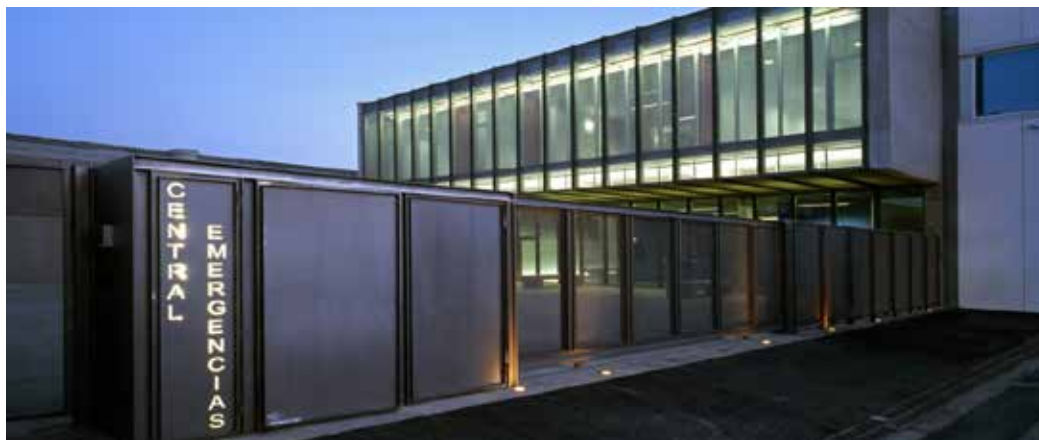
Centro de Emergencias en Alboraya.
