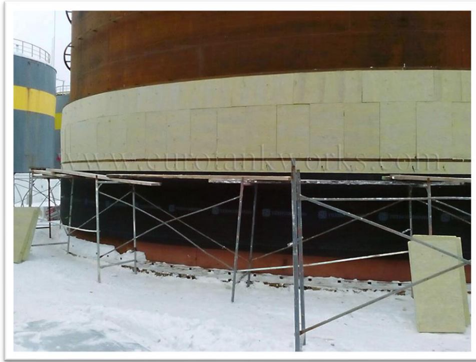
Figura 57. Recubrimiento con paneles de Poliuretano. Fuente: Eurotankworks
