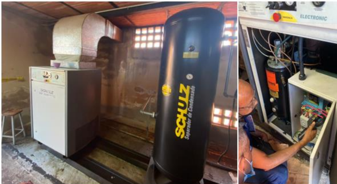
Figura 18: Compresor schulz SRP 3020 y medición de consumo
