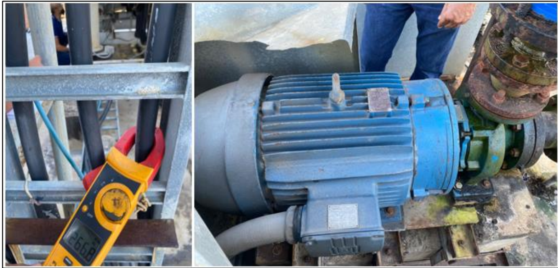
Figura 21: Consumo de los chillers y bomba de condensado de 40 hp
