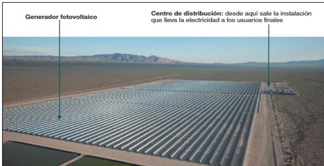
Figura 6: Complejo Copper Mountain Solar. Nevada. EEUU
