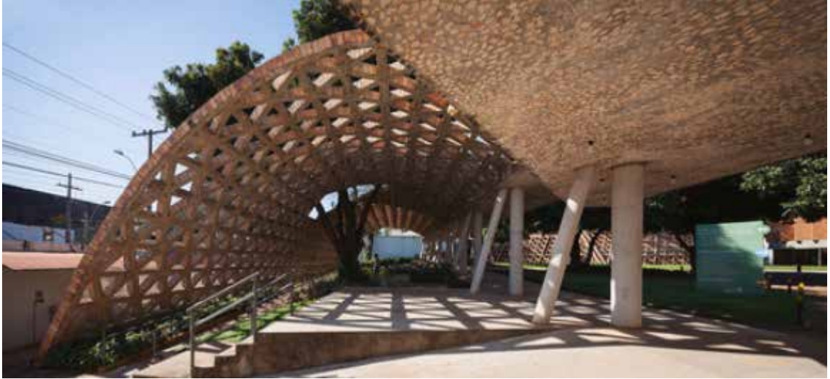
Figura 4: Vista del Centro de rehabilitación infantil de la Teletón. Fuente: https://www.plataformaarquitectura.cl/cl/773388/centro-de-rehabilitacion-infantil-de-la-teleton-gabinete-de-arquitectura
