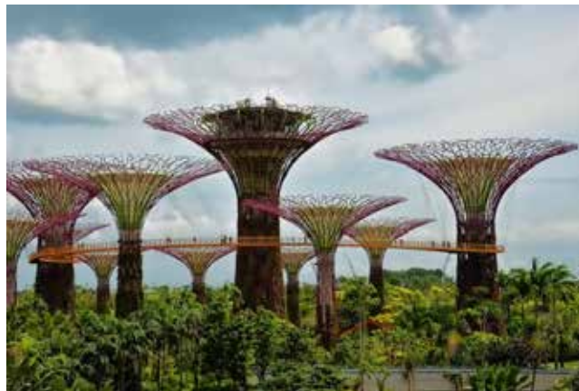
Figura 1: Vista de las torres de Gardens by the bay. Fuente: https://viajerosdelmisterio.com/los-super-arboles-de-singapur/
