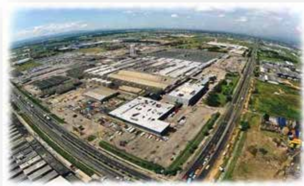
Figura 1. Vista Aérea de la Planta
