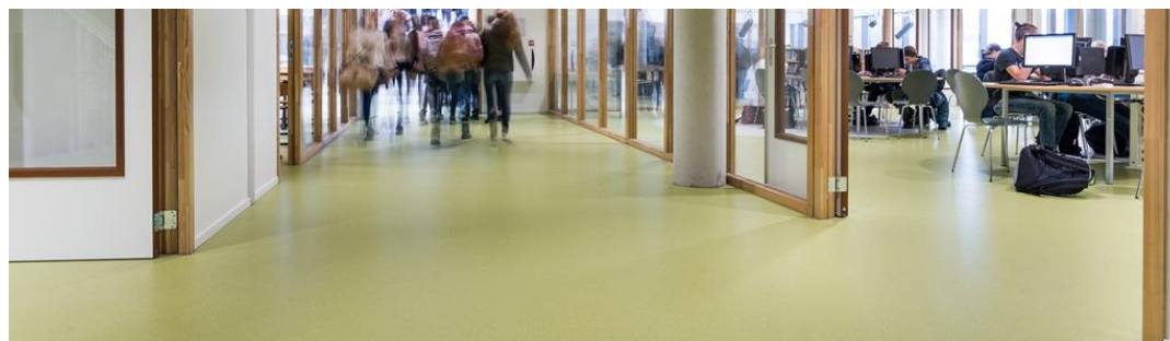
Imagen 27. Ejemplo de revestimiento de caucho tipo nora. Fuente: Autor desconocido (2021)
