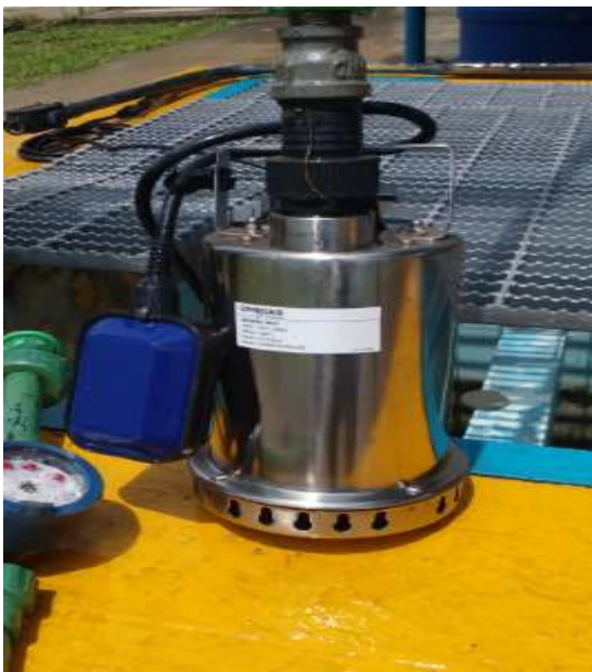
Bomba sumergible para tanque de cloración
