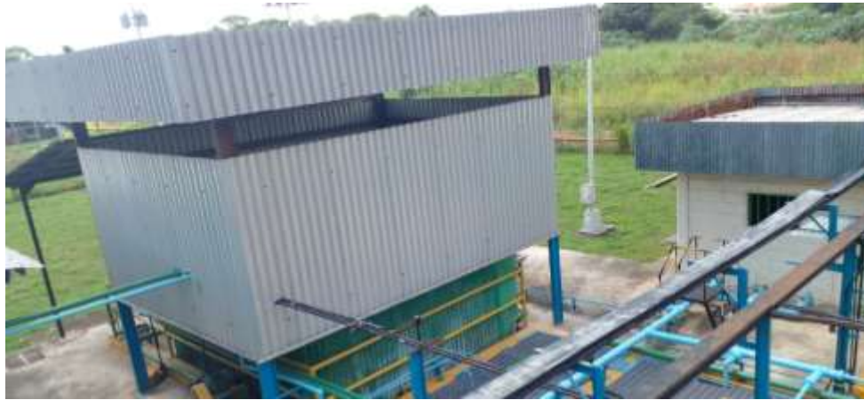
Figura 14. Tanquilla T – 13. Biodiscos
