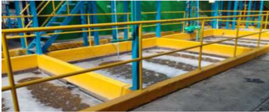
Figura 11. Tanquillas T – 05. Tanques de igualación
