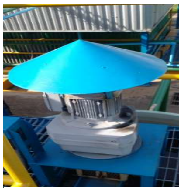
Motor reductor agitadores
