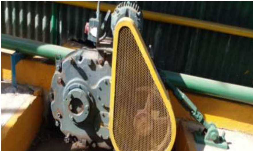
Motor reductor Biodiscos
