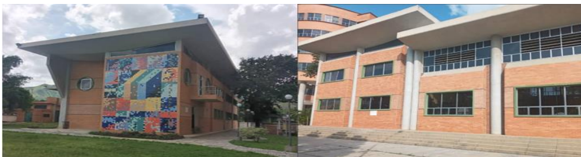
Figura 5. Edificio 5 Laboratorios de ingeniería civil y mecánica
