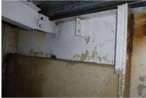
Figura 53: Reforzamiento del ala con planchas- tipo de estructura Fuente: Propia
