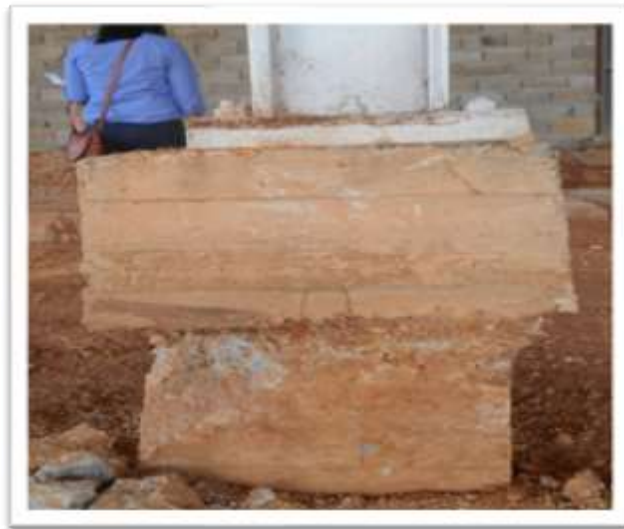
Figura 57: Tipo de suelo y cimentación supermercado Doce24
