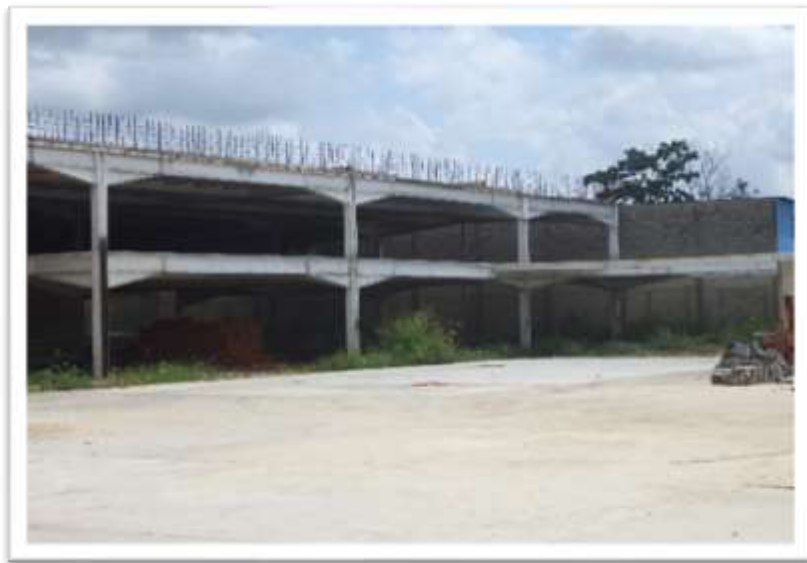
Figura 51: Configuración y forma de la edificación supermercado doce24 Fuente: Propia
