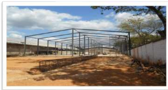
Figura 63: Tipo de estructura galpón Baruta Fuente: Propia
