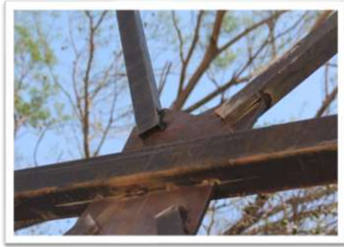
Figura 60: Calidad y estado de la construcción Galpón Baruta Fuente: Propia
