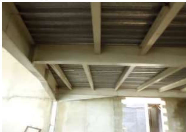
Figura 54: Correas -Tipo de estructura Fuente: Propia
