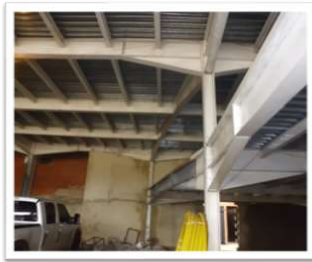
Figura 50: Falta de ortogonalidad en construcción del supermercado doce24
