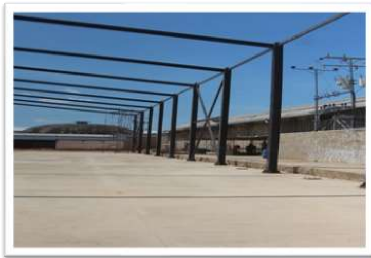
Figura 64: Tipo de estructura Galpón Baruta Fuente: Propia
