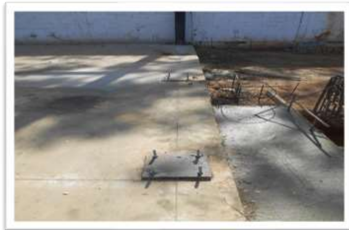
Figura 61: Calidad y estado de la construcción Galpón Baruta Fuente: Propia
