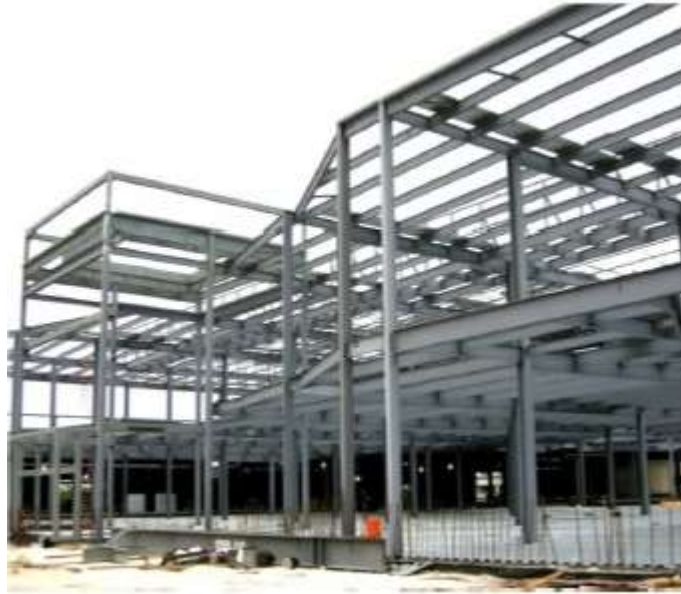
Figura 5. Estructura de pórticos no arriostrados.
