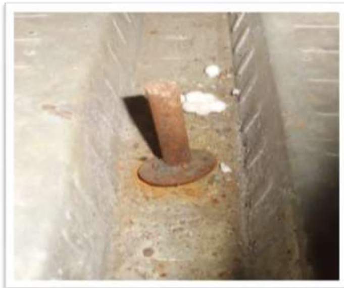
Figura 49: Apreciación de barras lisas en la construcción del supermercado doce24
