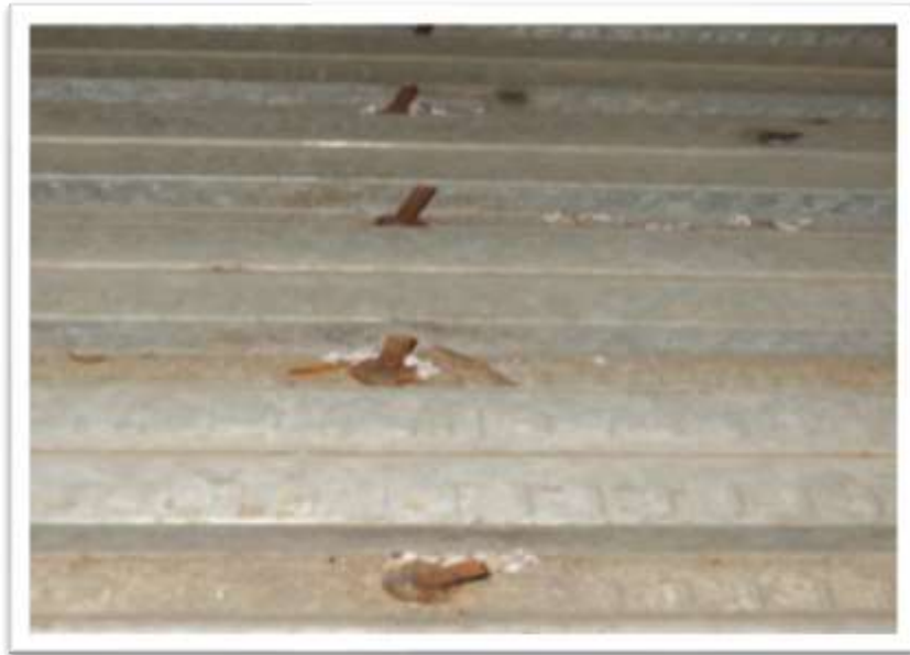
Figura 48. Calidad y estado de la construcción supermercado doce24
