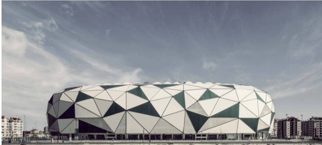
Figura 2: Estadio. Fuente: ( http://www.plataformaarquitectura.cl/cl/759753/estadio-de-la-ciudad-dekonya-bahadir-kul-architects ). (2014).
