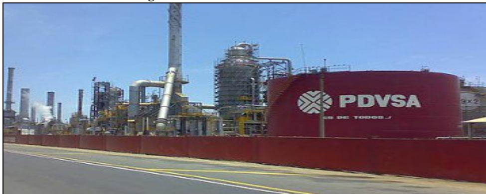
Figura No. 1: PDVSA Refinería El Palito
