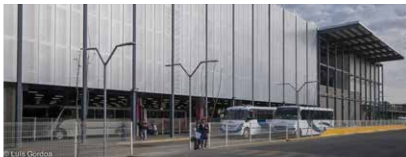
Figura 8 Paradero de Camiones
